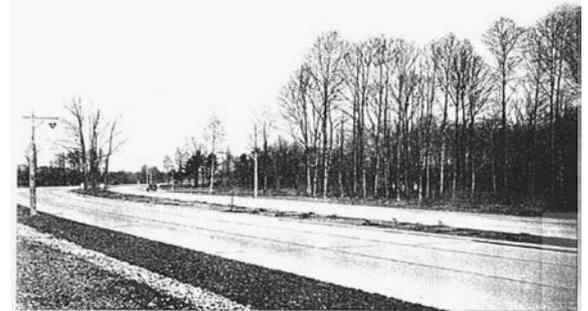
Abb. 5. Getrennter Richtungsverkehr (zwei 3 Fahrbahnen) nahe einer Kreuzung Trennungstreifen mit niedriger Bepflanzung. Alte Baumgruppen erhalten
