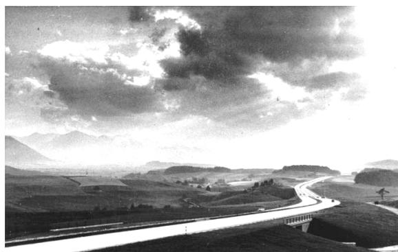
jeweilige vertikale Ausrundungsbogen der Straße wurde aus der mathematischen Funktion von Sichtdistanz, Bremsweg und Geschwindigkeit berechnet. Man sollte aus Gründen der Fahrsicherheit auch bei Gefällewechseln ein auf der Fahrbahn liegendes, 20 cm hohes Hindernis erkennen können (Abb. 71).<sup>27</sup>
