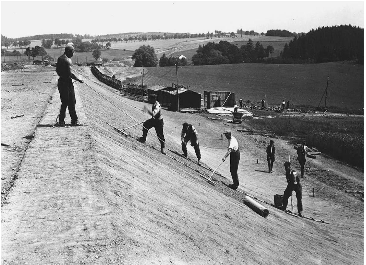
schen 25 und 80 cm an.<sup>15</sup> Die Tiefe der Schicht variierte je nach Standort. Das Wiederandecken der Böschungen mit Mutterboden wird dem Tiefbauunternehmer überlassen.
