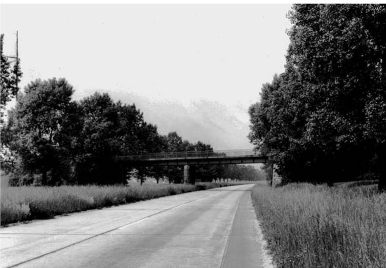
*165 Stahlblechträgerbrücke mit werkseitig verkleideten Betonpfeilern.*
