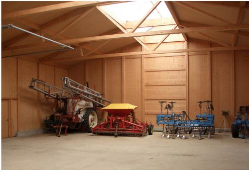
Abb. 1: Maschinenhalle in Holzbauweise
