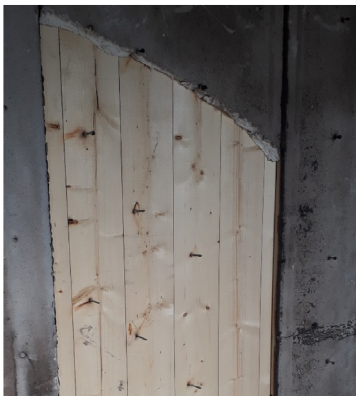
Abb. 11: Verbindungsmittel nach Entfernen der Brandschutzbekleidung, Versuch V0 aus TIMpuls
