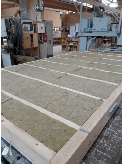
Abb. 17: Holztafelbauwand Steinwolldämmstoff im Gefach – vor dem Aufbringen der Bekleidung
