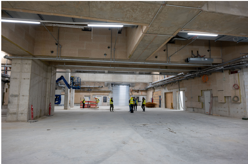
Abb. 4: Raumhohe Transferbalken mit thermischer Hülle
