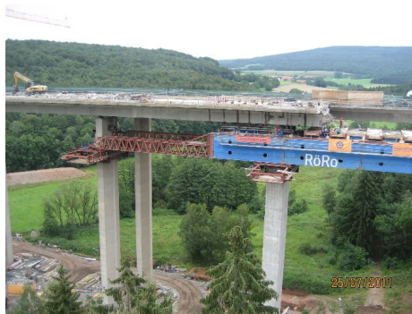
Abb. 2 Rückbauzustand der Döllbachtalbrücke mit Verankerung der Längsspannglieder über Verbund
