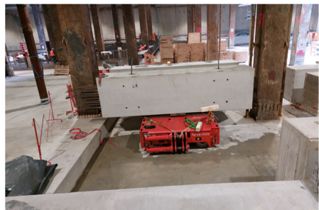
Abb.3: temporärer Aussteifungsrost in der Ebene E-2 / Montage der FT
