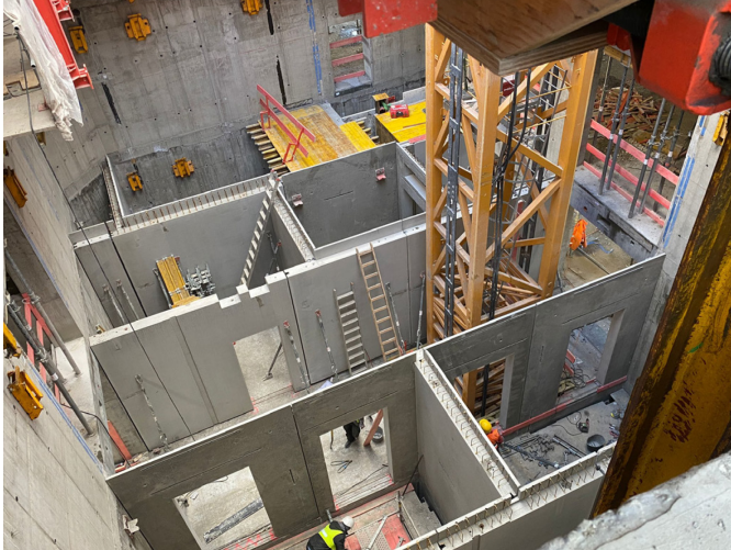
Abb. 9: Kernwände als Betonfertigteile
