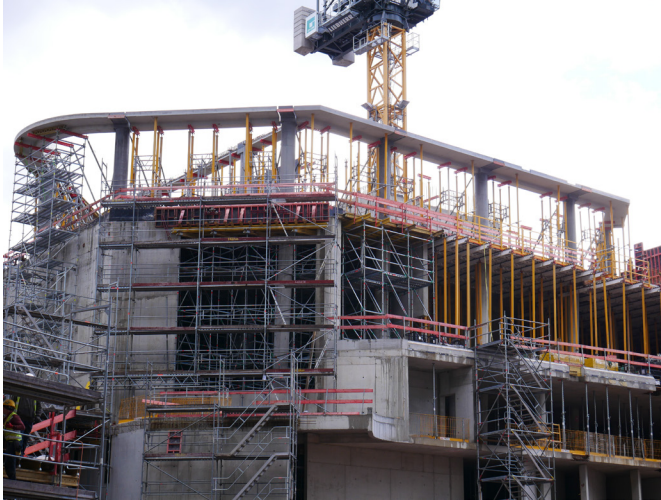
Abb. 5: Montagezustand der Halffertigteildecke
