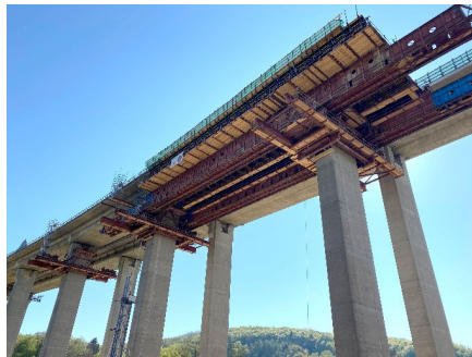
Abb. 1 Abschnittsweiser Rückbau des Überbaus der Talbrücke Unterrieden auf Vorschubrüstung
