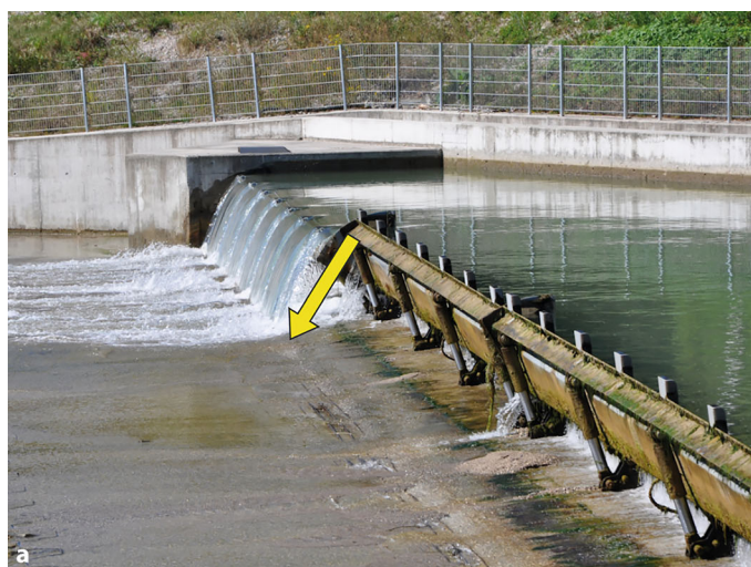
Abb. 8 a Klappenwehr ohne Unterwasserpolster, b Beschleunigungsprofil, das mit dem Sensorfisch bei der Passage des Klappenwehrs aufgezeichnet wurde. (Die Spitzenausschläge der blauen Linie zeigen Kollisionsereignisse an. Die Beschleunigung wird als Faktor der Erdbeschleunigung g ( = 9,81 \text{ m/s}^2 ) angegeben)
