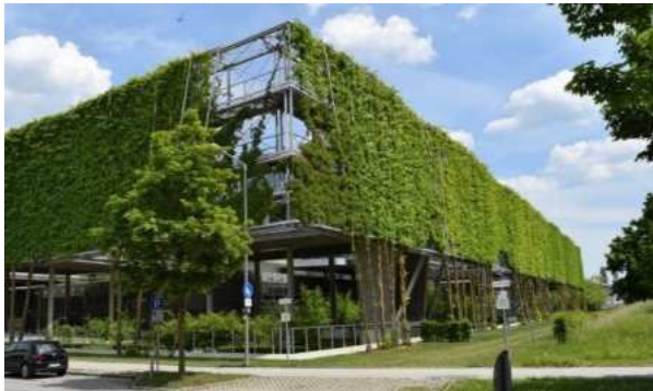
Bild 2: Bodengebundener Bewuchs an Kletterhilfen (Swiss Re Bürogebäude München); (Quelle: Bundesverband GebäudeGrün)
