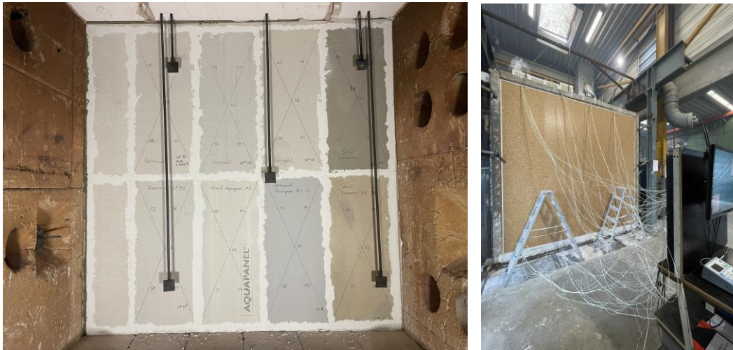
Abbildung 115: Eingebauter Prüfkörper im Prüfofen von innen (links) und von außen (rechts) ■
