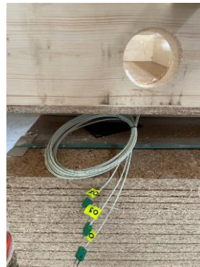
d) Fixierung der Kabelführung
