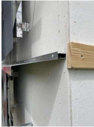
5. Hinterlüftung PV-Fassade
