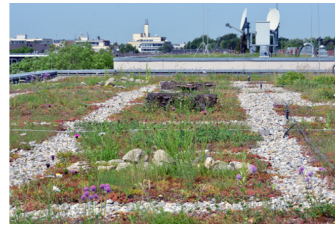
In der Brantstraße, einem Wohnungsbauprojekt in München-Laim, wurde unter Mitwirkung von AAD ein Gründach mit Vegetation durch Totholz, Steinhaufen und Sandflächen zu einem tiergerechten Gründach erweitert.
