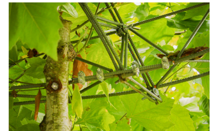
Bei der Baubotanik werden lebende und nicht lebende Konstruktionselemente so miteinander verbunden, dass sie zu einer pflanzlich-technischen Verbundstruktur verwachsen.
