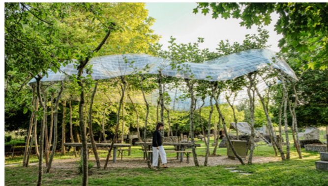
Arbor Kitchen ist ein baubotanisches Versuchsbauwerk im Skulpturenpark Neue Kunst am Ried, Baden-Württemberg. Die Überdachung ist so konstruiert, dass sie von den Bäumen getragen wird und deren natürlichen Wachstumsprozessen Rechnung trägt.
