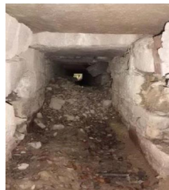
Abbildung 2-2: Zerstörter Durchlass [1.1 - 1]
