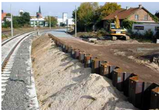
Abbildung 2-5: Abgetrennte Spundwand verbleibt im Boden [1.1 - 1]
