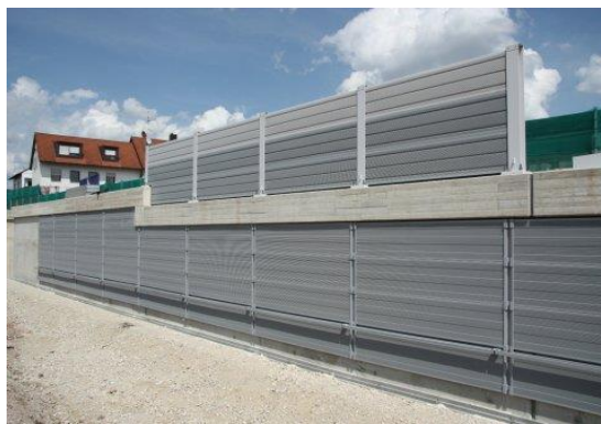
Abbildung 2-6: Neu errichtete Lärmschutzwand [1.1 - 1]
