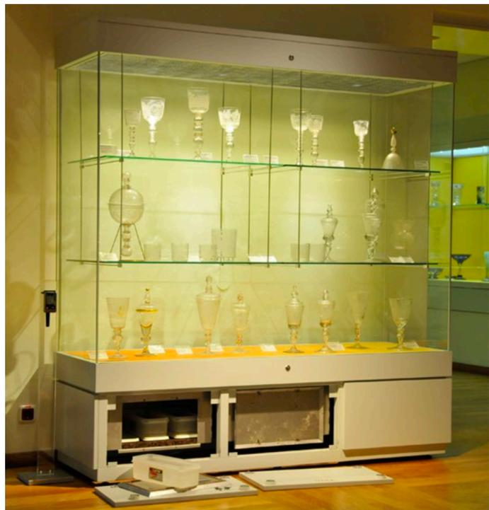
Abbildung 2-34: Vitrine auf der Veste Coburg mit Magnesiumchloridlösung in Kunststoffbehältern im unteren Teil während der Wartung (Eggert 2022)
