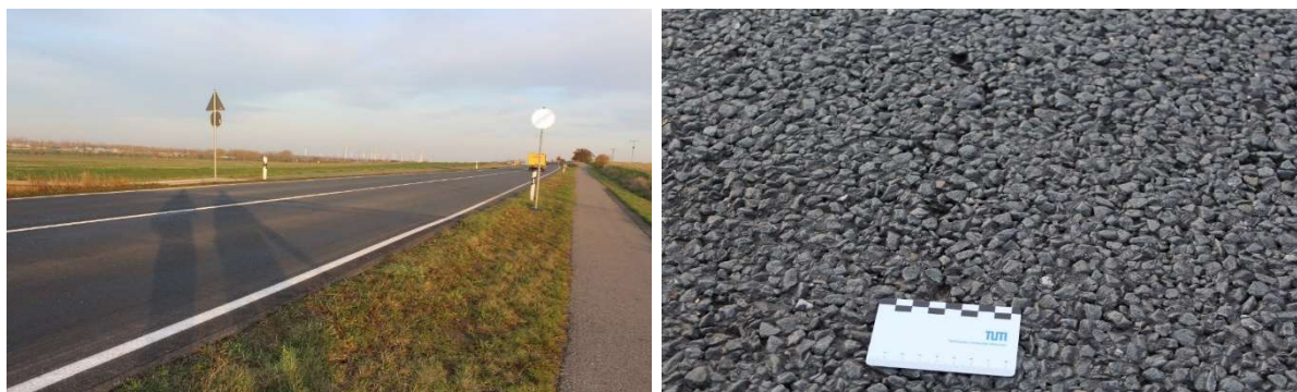
Abbildung 4-1: Fotodokumentation der Streckenbesichtigung B 81 Heyenburg - Kroppenstedt [8]
