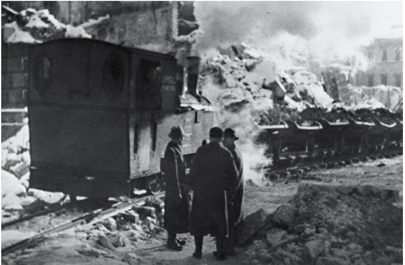
Abtransport von Bauschutt vom Gelände der TH München mit der sogenannten »Bockerlbahn«, um 1946 TUM.Archiv, FotoB.
