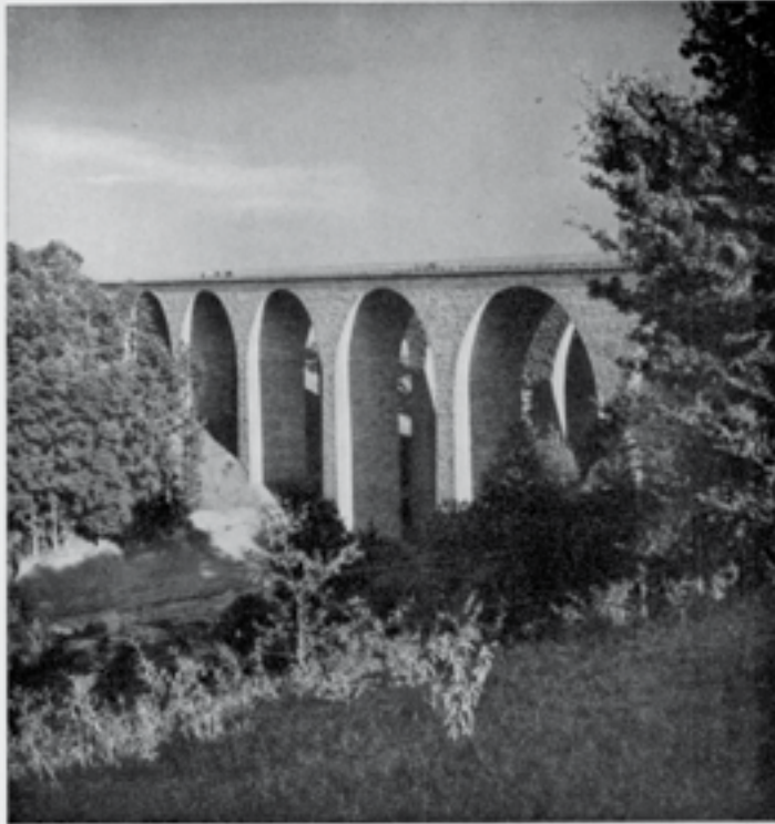
Abb. 173. Waschgöhltaalbrücke der Reichsautobahn bei Kaiserslautern
