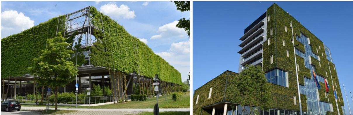
Abb. 2: Beispiele für begrünte Fassaden, links bodengebundenen Bewuchs an Kletterhilfen (Swiss Re Bürogebäude München), rechts wandgebundenes Begrünungssystem (Stadtverwaltung Venlo Niederlande); (Quelle: Bundesverband GebäudeGrün)
