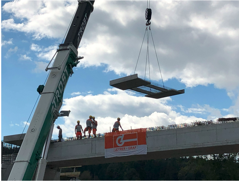
Abb. 4: Einheben eines Fahrbahnplattenelements bei der Pinkabachbrücke (Foto: TU Wien)
