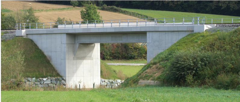
Abb. 3: Erstanwendung des LT-Brückenbauverfahrens bei der Pinkabachbrücke (Foto: Fabian Fritz)
