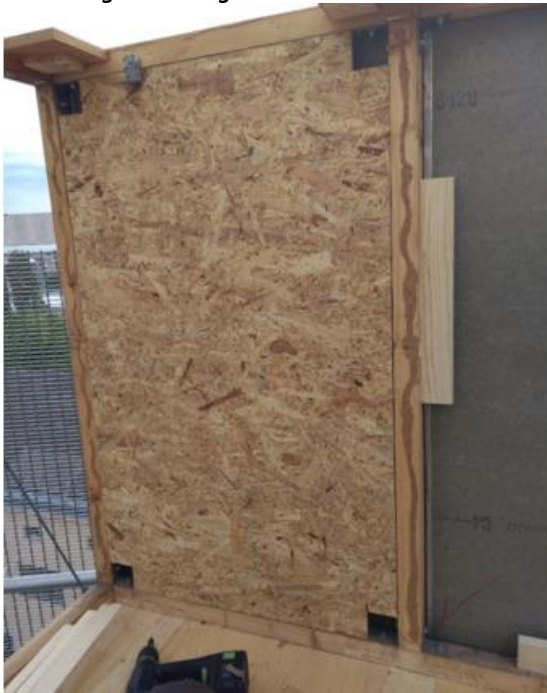
Abbildung 54 Montage OSB
