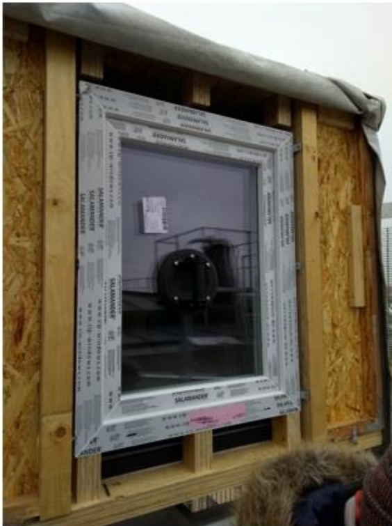
Abbildung 66 Fenstereinbau (links) Fenster abkleben (rechts)
