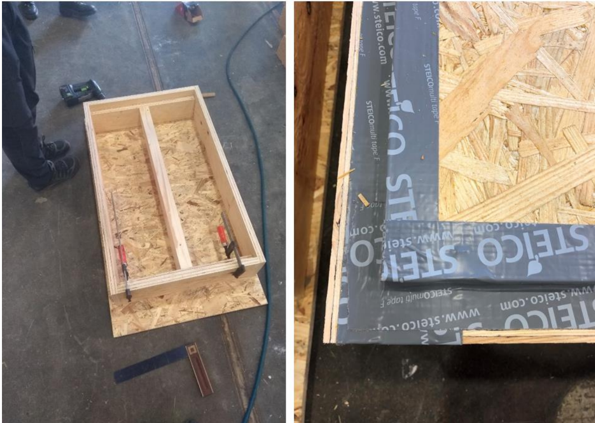
Abbildung 60 Testelemente Holzrahmenbau (links) luftdichte Abklebung (rechts)
