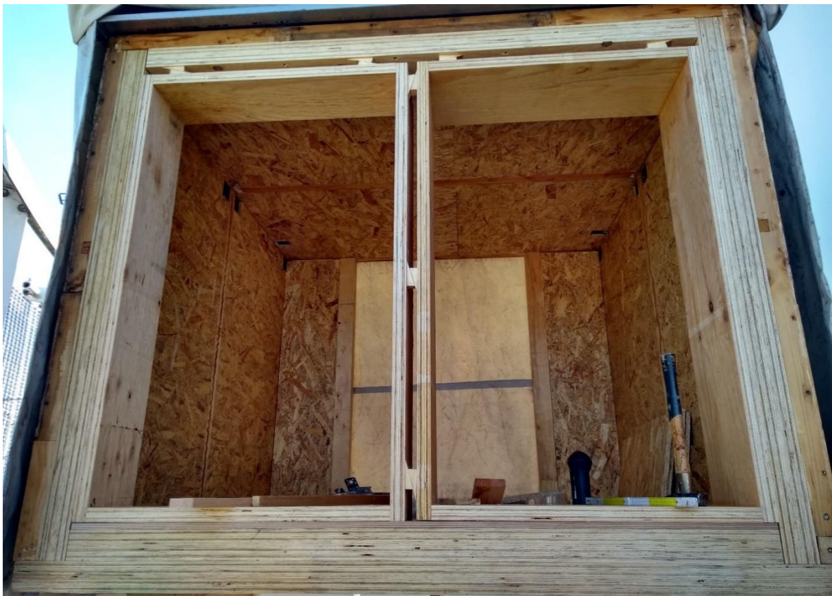
Abbildung 58 Testweises verkleben der Rahmen (Vollbild)
