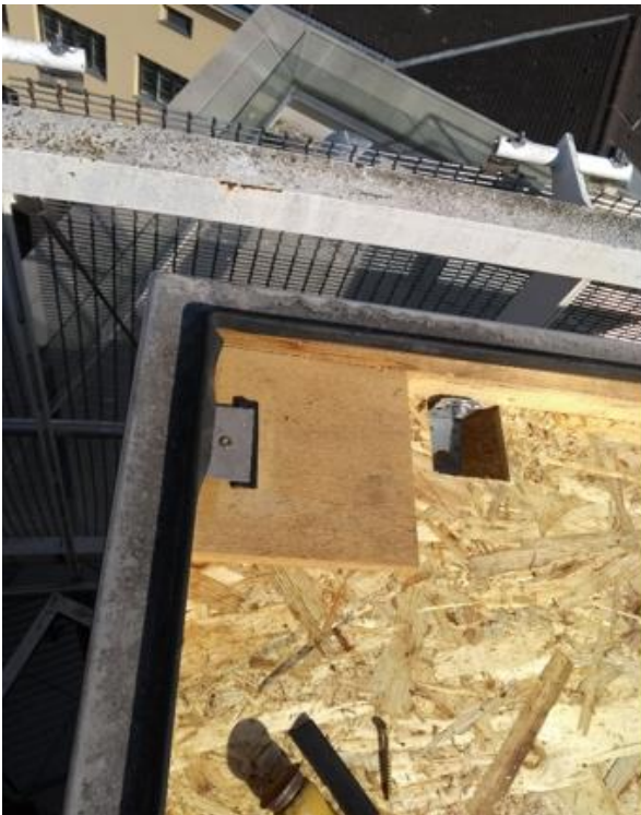
Abbildung 56 Remontage des metallenen Dachrahmens (links) und fertig beplankter Innenraum (rechts)
