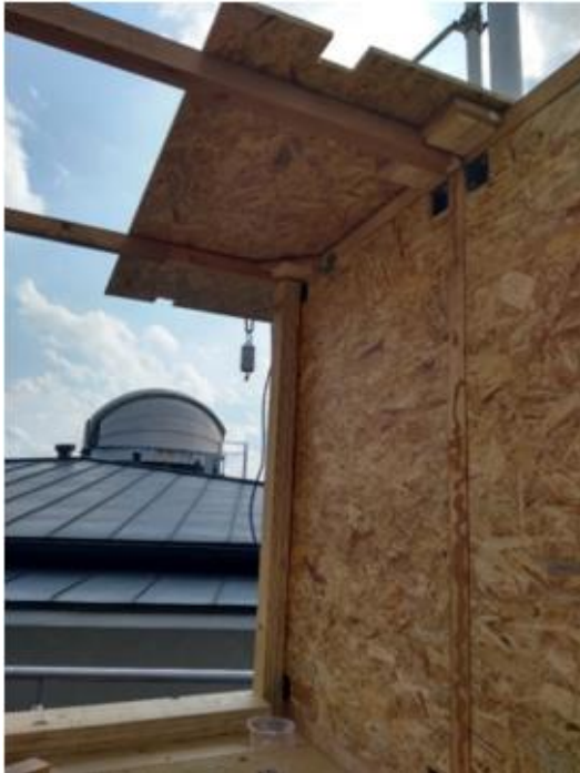
Abbildung 55 Rahmendoppel (links) und Fensterlaibung (rechts)
