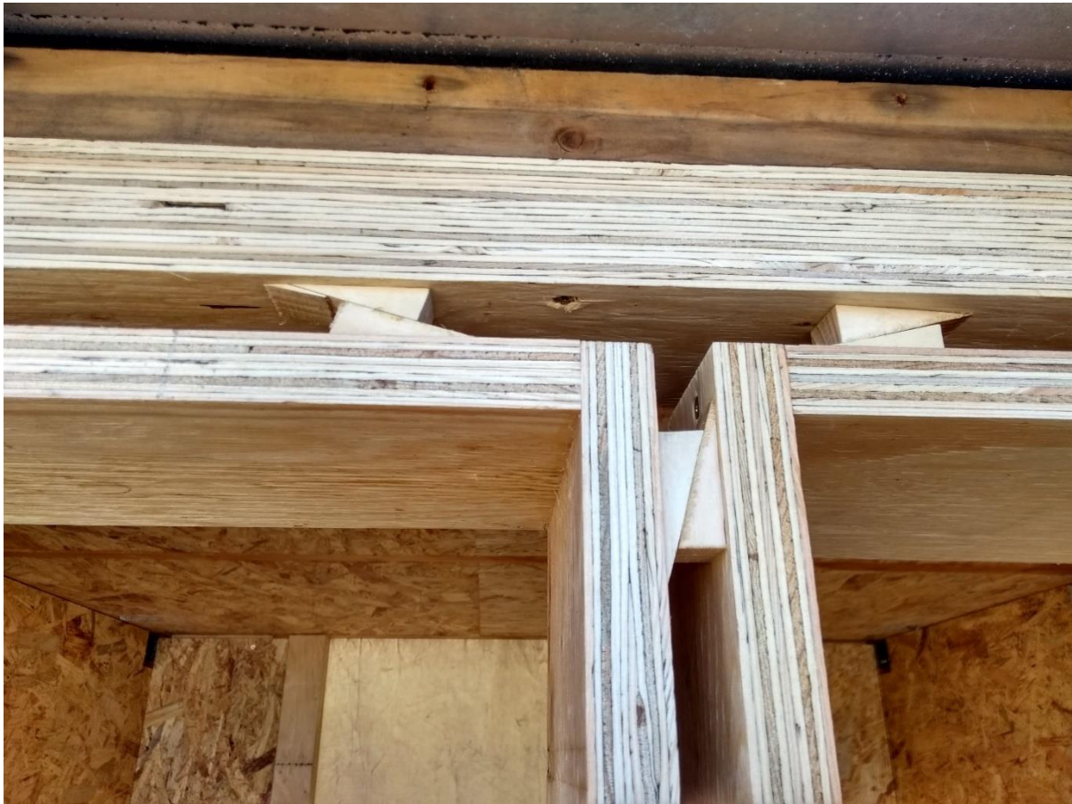
Abbildung 59 Testweises verklotzen der Rahmen (Detail)
