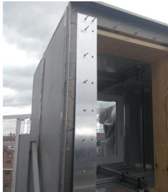
Abbildung 69 Bitumenversiegelung des Kubus (links) Bleche für den Witterungsschutz der Bauteile (rechts)
