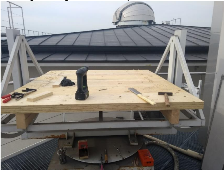
Abbildung 53 Montage der neuen Bodenplatte
