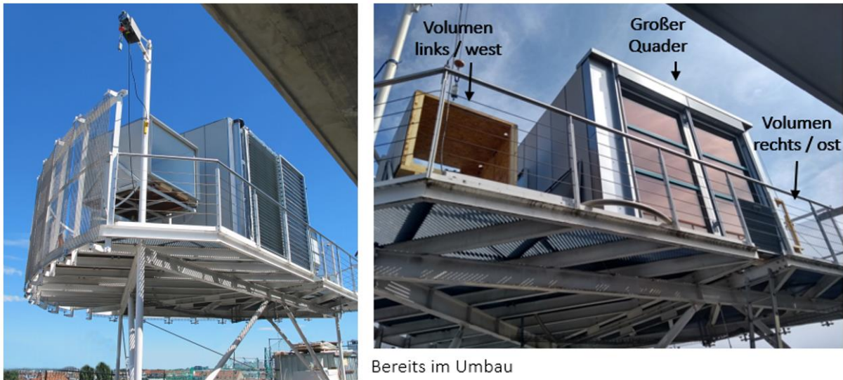
Abbildung 49 Solarstation auf dem Dach des TUM Hauptgebäudes
