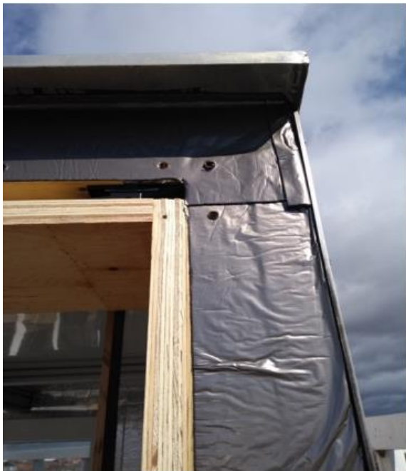
Abbildung 69 Bitumenversiegelung des Kubus (links) Bleche für den Witterungsschutz der Bauteile (rechts)
