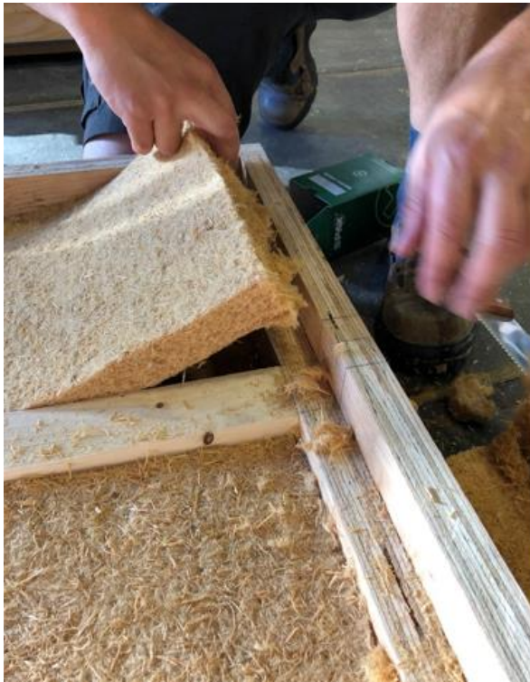
Abbildung 62 Einlegen der Holzfaserdämmung in die Holzrahmenbauwand (links) und Holzfaserplatte auf das Element (rechts)
