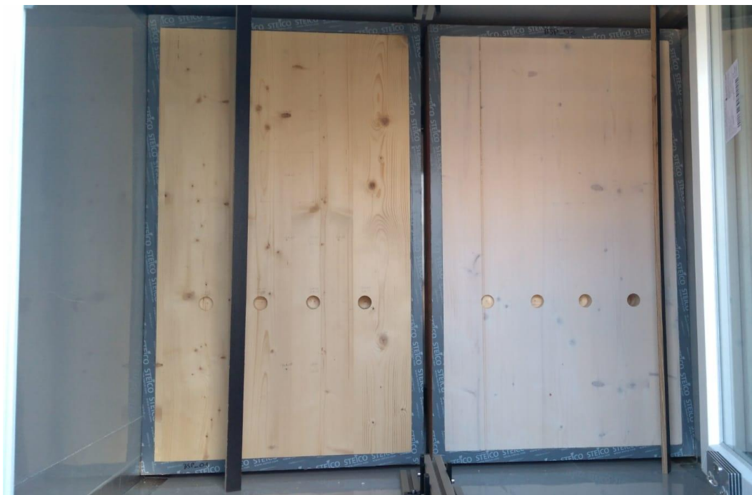
Abbildung 72 Abgeschlossene Montage der Wandtestelemente, Innenansicht
