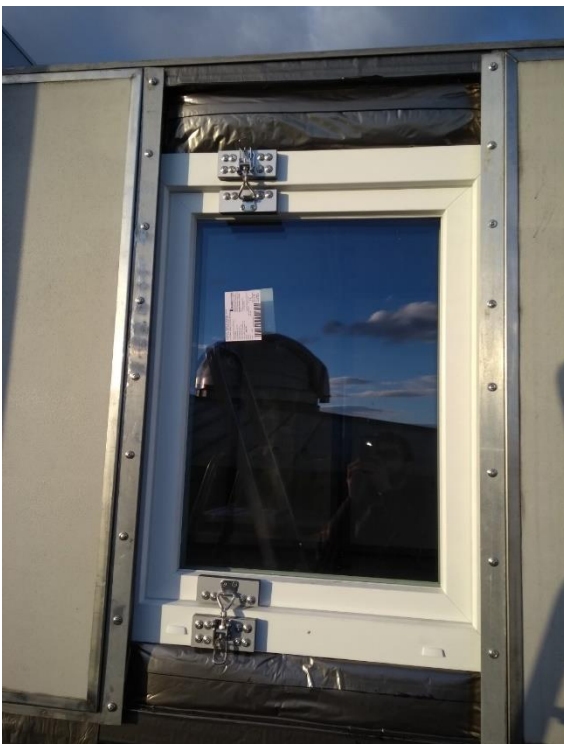
Abbildung 67: Fenster fertig eingebaut
