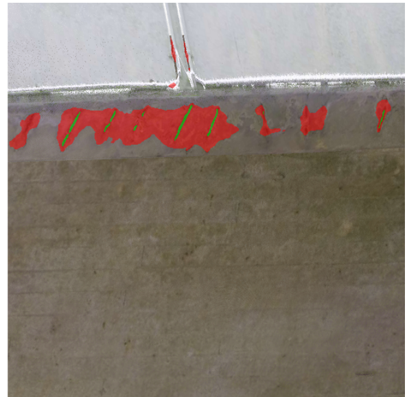
Abbildung 59: Punktwolke von einer Betondecke mit mehreren Abplatzungen und freiliegenden korrodierten Bewehrungsstäbe. Das FPN-Modell erkennt viele Abplatzungs- und Korrosionsobjekte.
