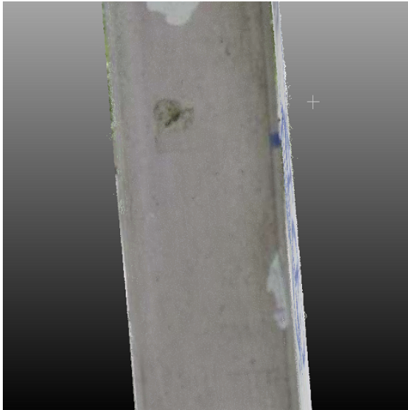
Abbildung 58: Punktwolke von einer Stütze mit einer Abplatzung und einer freiliegenden korrodierten Bewehrung. Das FPN-Modell erkennt im Bild die Abplatzung, jedoch nicht die Korrosion der Bewehrung
