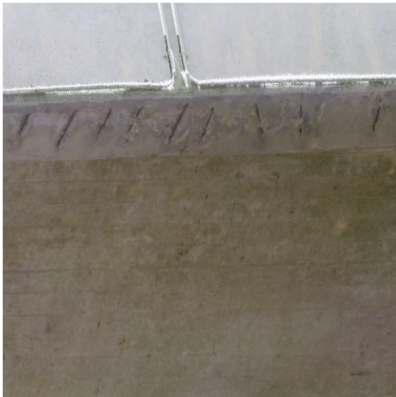
Abbildung 59: Punktwolke von einer Betondecke mit mehreren Abplatzungen und freiliegenden korrodierten Bewehrungsstäbe. Das FPN-Modell erkennt viele Abplatzungs- und Korrosionsobjekte.
