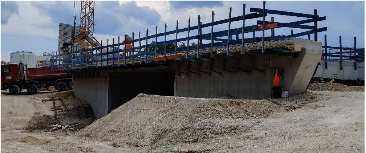
Abbildung 3: Bauwerk 43 auf der A 9 Nürnberg-München (Quelle: TUM).
