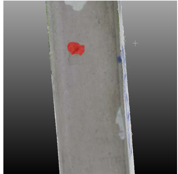
Abbildung 58: Punktwolke von einer Stütze mit einer Abplatzung und einer freiliegenden korrodierten Bewehrung. Das FPN-Modell erkennt im Bild die Abplatzung, jedoch nicht die Korrosion der Bewehrung
