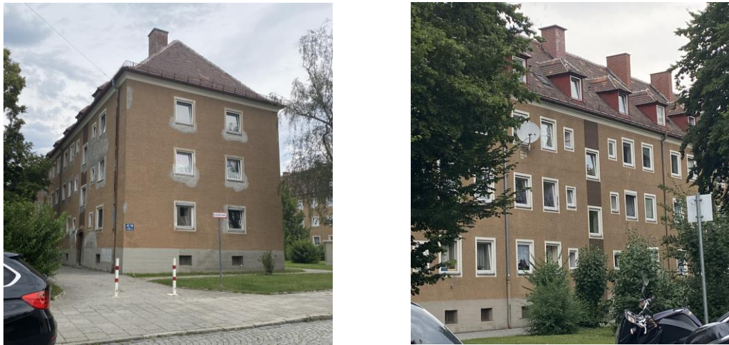
Abbildung 5-2: Bestandsgebäude im Bestandsquartier Moosach; eigene Bilder
