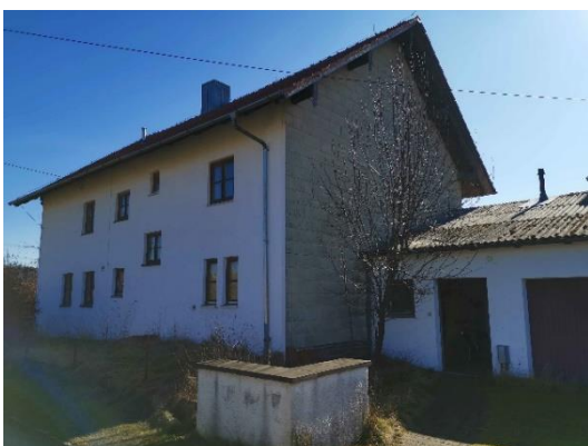
Abbildung 15: Sanierungsobjekt Nordwestansicht (eigene Aufnahmen)
