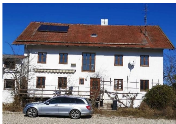
Abbildung 16: Sanierungsobjekt Südansicht (eigene Aufnahmen)
