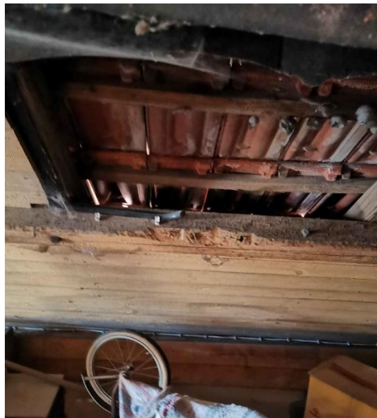
Abbildung 18: Sanierungsobjekt Dachaufbau (eigene Aufnahmen)
