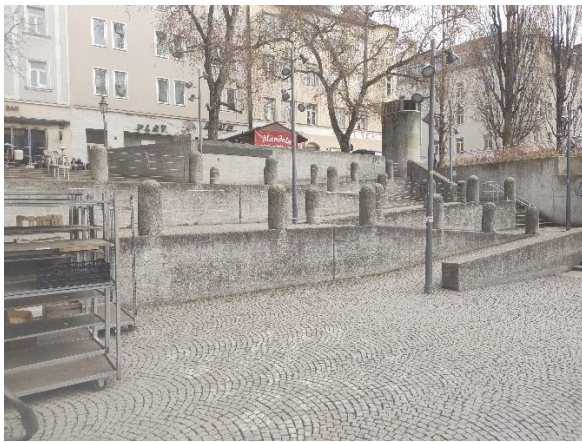
Abbildung 6: Rampe an der Münchner Freiheit. Personen können die Treppe oder die Rampe nehmen, um zur U-Bahn zu gelangen. Im Hintergrund (rechts) ist die Treppe zu sehen.
