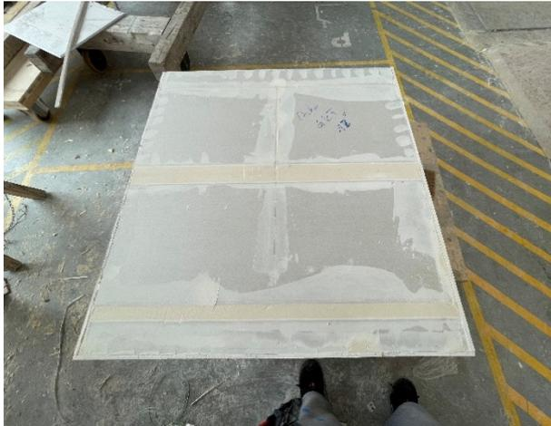
Abbildung A.13.8-1: Deckenkonstruktion im Bau, GKF Fugen verspachtelt
