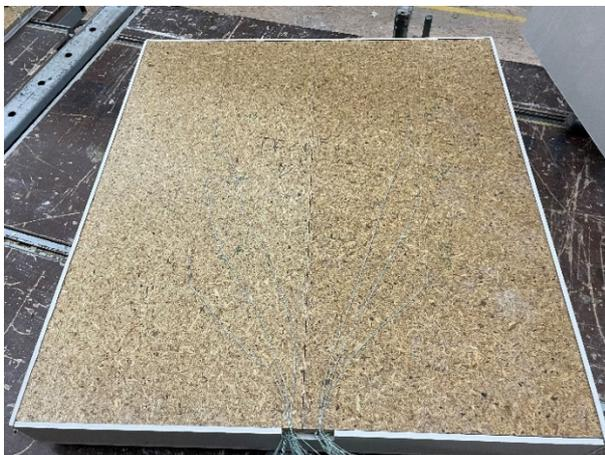
Abbildung A.12.7-3: Deckenkonstruktion im Bau mit Spanplatte
