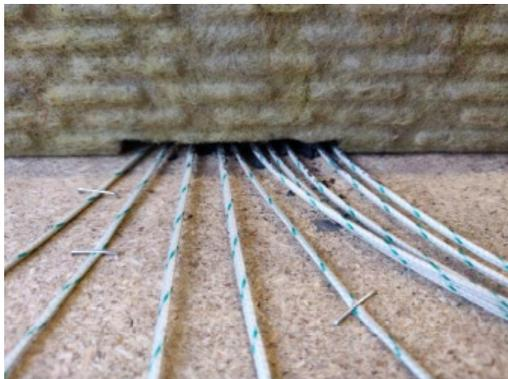
Abbildung A.9.4-3: Auskerbung der Mineralwoll-dämmplatte
