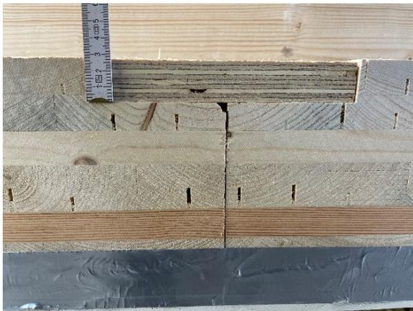
Abbildung A.11.7-3: Ausbildung der Stoßfuge zwischen den BSP-Elementen
