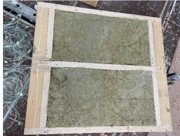
Abbildung A.12.7-2: Deckenkonstruktion im Bau mit Steinwolle
