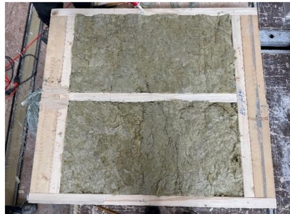
Abbildung A.14.7-2: Deckenkonstruktion im Bau mit Steinwolle
