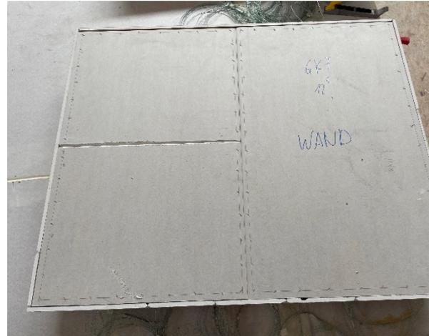
Abbildung A.13.8-2: Wandkonstruktion im Bau, Befestigung GKF
