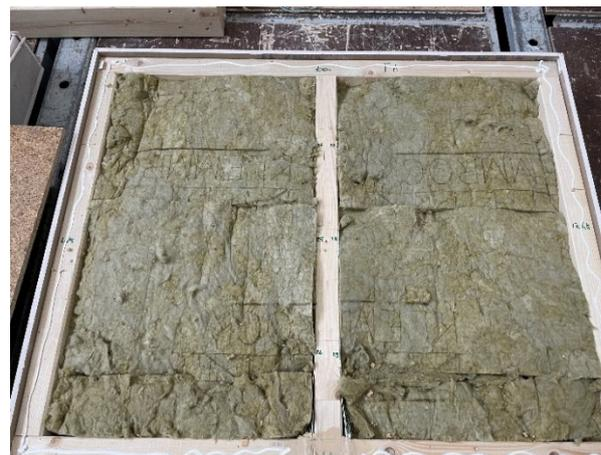
Abbildung A.12.7-6: Wandkonstruktion mit Steinwolle
