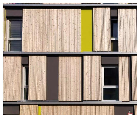
Abb. 3: Fassade als vertikale Nut-und-Feder-Schalung
