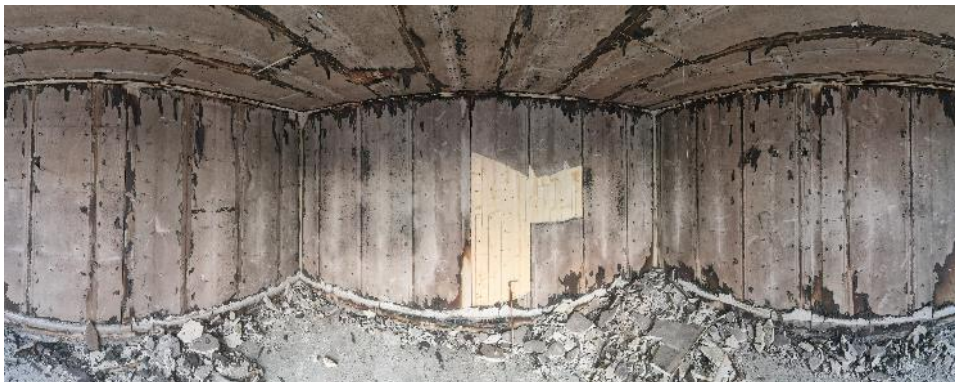
Abbildung 297: Brandraum V0 am Folgetag, Brandschutzbekleidung teilweise geöffnet
