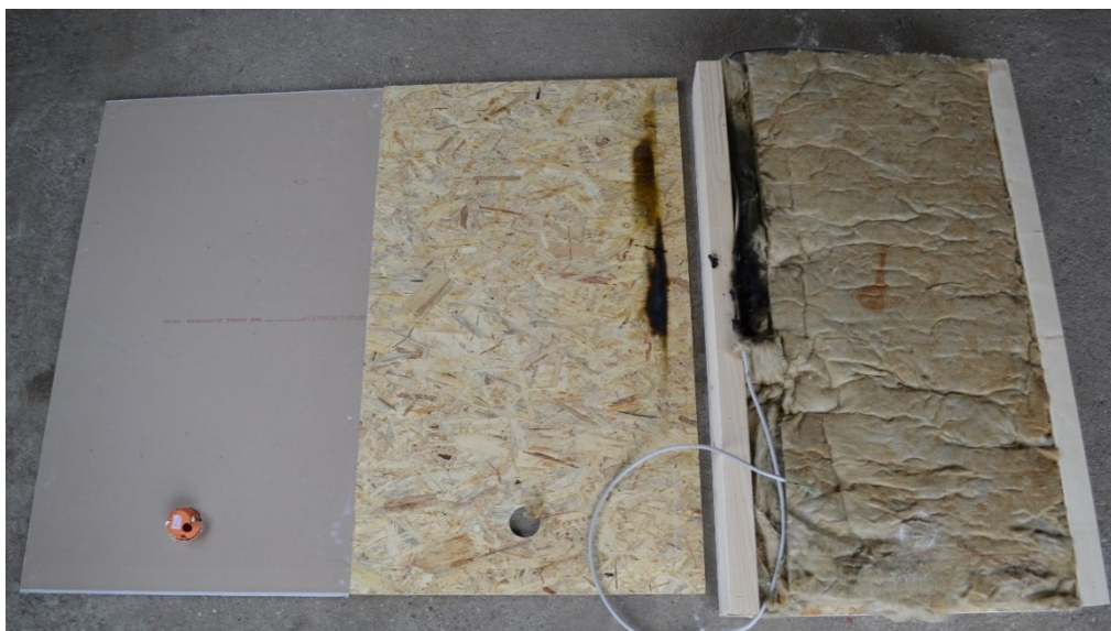
Abbildung 119 : Prüfkörper mit am Ständer verlegtem PVC-Kabel nach Öffnung und Lichtbogeneinwirkung [95]
