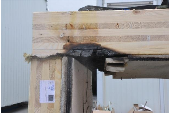
Abbildung 2: Brandbeanspruchte Ecke Wand-Deckenanschluss in Massivholzbauweise
