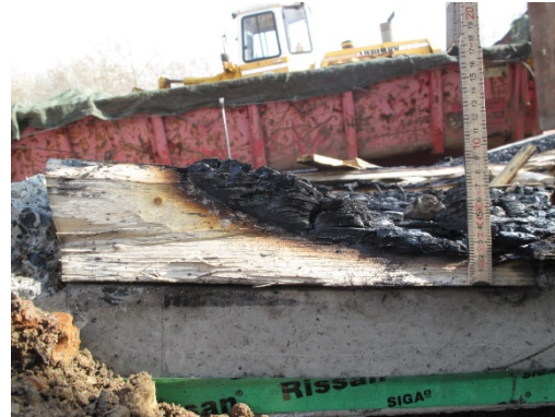
Abbildung 155: Auflager Brennerseite geöffnet
