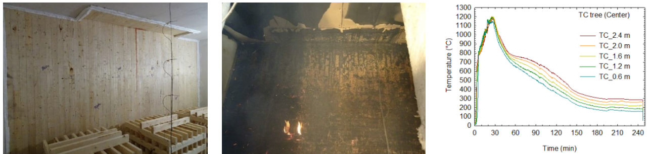
Abbildung 269: unbekleidete Wand A und teilweise unbekleidete Decke im Brandversuch Test 2 [201], vor (links), zur 240. Versuchsminute (Mitte) und der Temperaturzeitverlauf im Brandraum (rechts)
