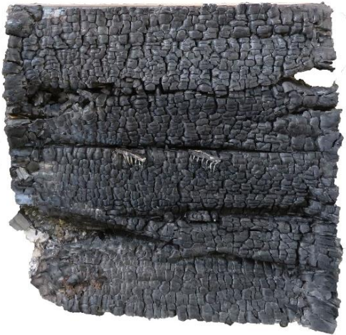
LH_VH_Bu_NBH_1D brandbeanspruchte Seite, Kohleschicht
