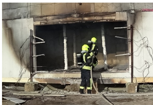
Abbildung 224: 158. Minute V3: Löschkräfte betreten den Brandraum
