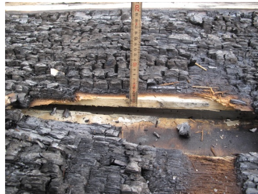
Abbildung 157: Koppelbrett freigelegt
