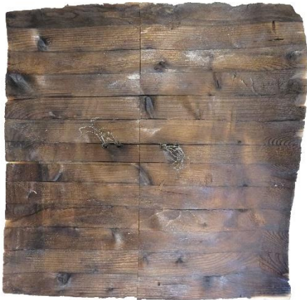
— NH_BSH_Fi_NBH_1D brandbeanspruchte Seite, Kohleschicht entfernt
