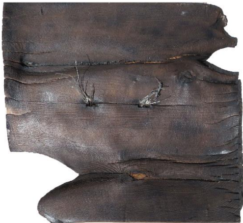
LH_VH_Bu_NBH_1D brandbeanspruchte Seite, Kohleschicht entfernt
