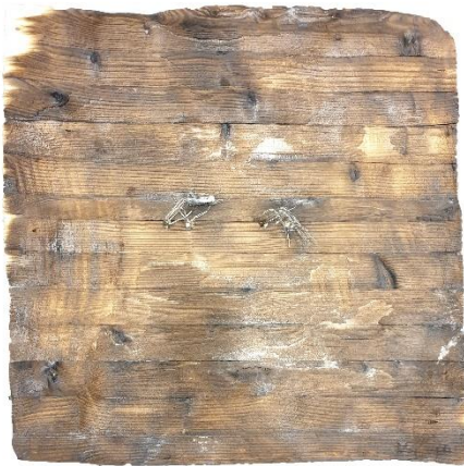
NH_BSH_Fi_ETK_1D brandbeanspruchte Seite, Kohleschicht entfernt
