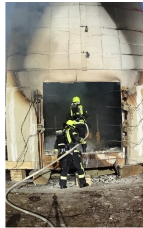
Abbildung 199: 100. Minute V1: Löschkräfte betreten den Brandraum
