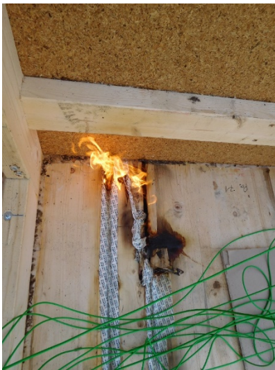
Abbildung 229: Nachkontrolle V3: Einbrand in die Fuge
