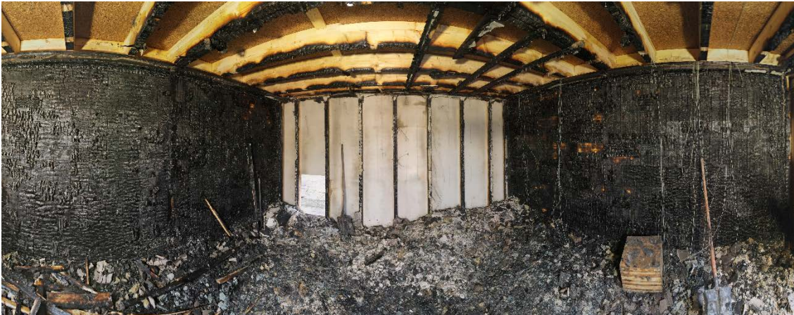
Abbildung 257: 360° Drohnenaufnahme der Bauteiloberflächen nach Demontage der Brandschutzbekleidung und Gefachdämmung für V2
