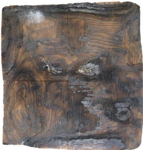
NH_FSH_Fi_NBH_1D brandbeanspruchte Seite, Kohleschicht entfernt
