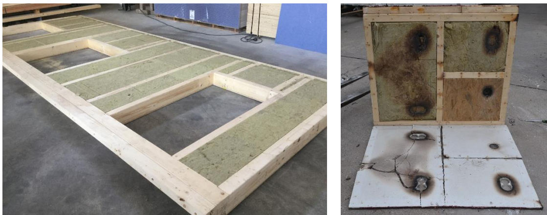
Abbildung 4: Beispiel für mineralisch gedämmte Holztafelbauwand (Überwachungsstelle MPA BAU TU München) und Wandelement nach 60 Minuten Brandversuch mit entfernter Bekleidung.
