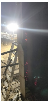
Abbildung 231: Foto ca. 2 h nach Versuchsende V3: Glimmen des Ständers der Laibung der Brandraumöffnung
