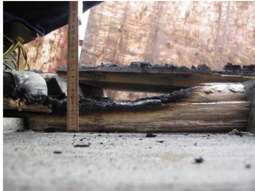
Abbildung 154: Auflager Abzugsseite geöffnet
