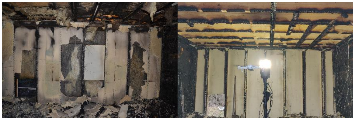
Abbildung 299: Brandraum V2 nach Versuchsende (links), Brandschutzbekleidung und Dämmstoffe zurückgebaut (rechts)
