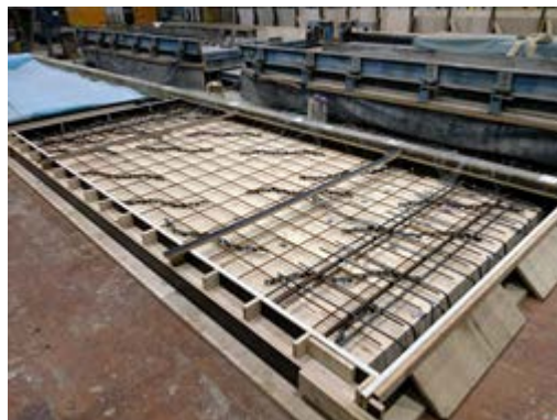
Abbildung 321: Holzschicht und Bewehrungslage der Holz-Beton-Verbunddecke in der Herstellung (links) und Ausführung von Temperaturmessstellen in der Grenzschicht zwischen Holz und Beton sowie an der Bewehrung (rechts)
