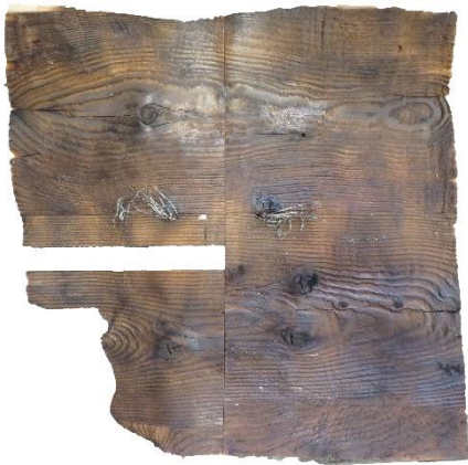
NH_VH_Fi_NBH_1D brandbeanspruchte Seite, Kohleschicht entfernt
