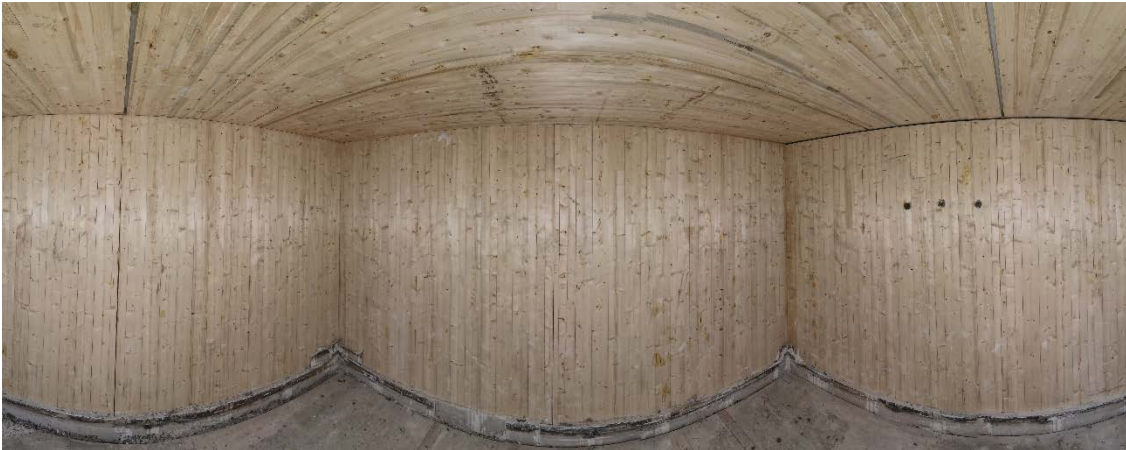
Abbildung 253: 360° Drohnenaufnahme der Massivholzoberfläche nach Demontage der Brandschutzbekleidung für V0
