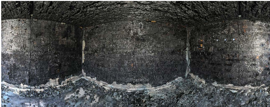
Abbildung 255: 360° Drohnenaufnahme der Massivholzoberfläche nach Demontage der Brandschutzbekleidung für V1
