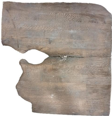
LH_BSH_Es_NBH_1D brandbeanspruchte Seite, Kohleschicht entfernt
