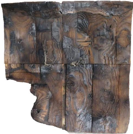
NH_BSP_Fi_NBH_1D brandbeanspruchte Seite, Kohleschicht entfernt
