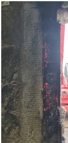
Abbildung 214: ca. 3 h nach Versuchsende V2: Glimmen am Holzstände der Öffnungslaibung
