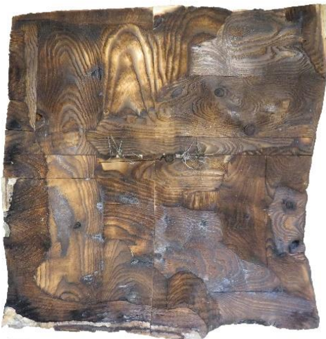
NH_BSP_Fi_ETK_1D_Akusta2 brandbeanspruchte Seite, Kohleschicht entfernt
