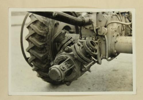
Anbau-Kreiselpumpe zum Einachsschlepper ET 19/9.5
