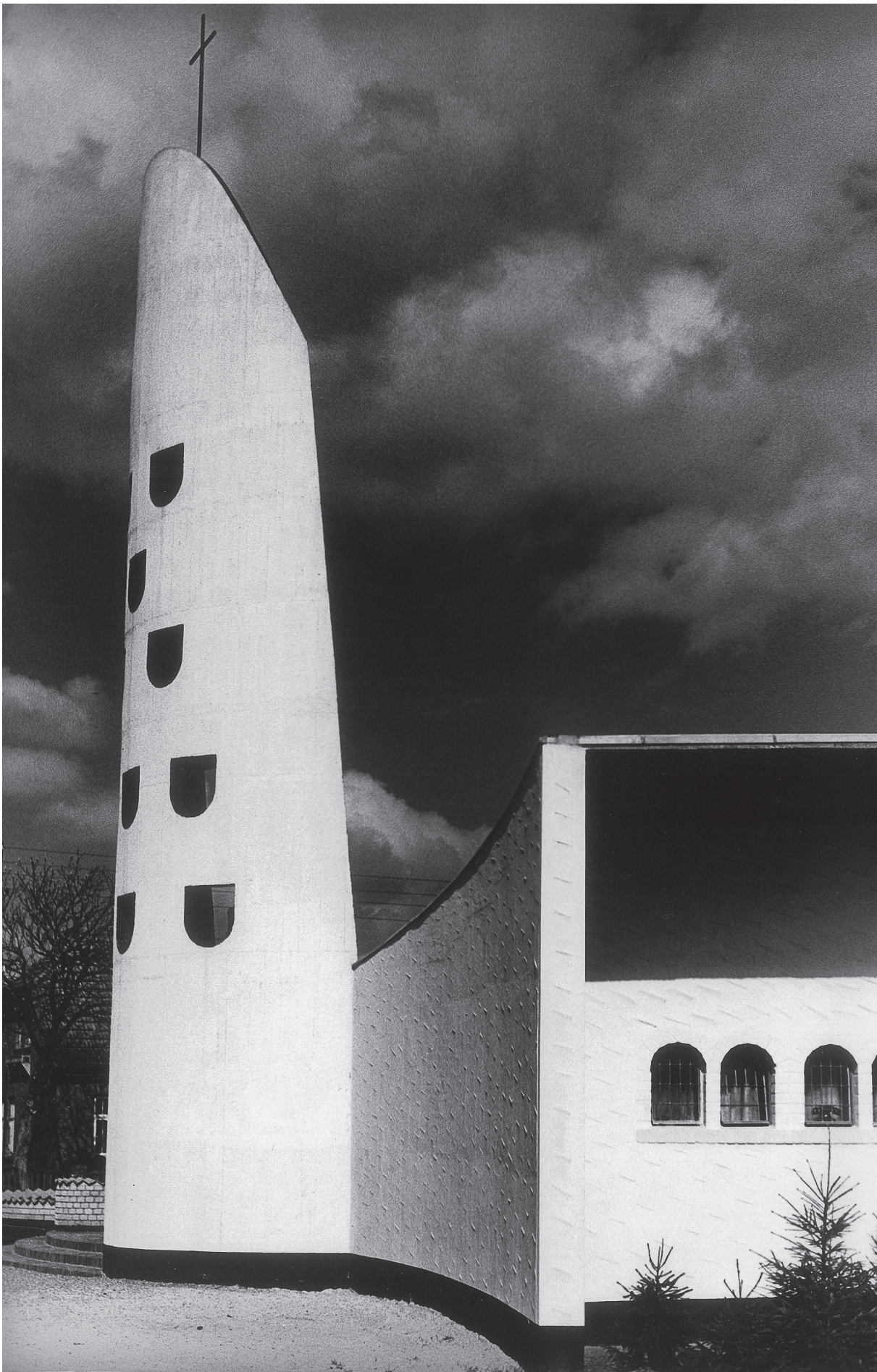
HI. Dreifaltigkeit, Schortens, Glockenträger und Sakristei kurz nach Fertigstellung → S. 59
