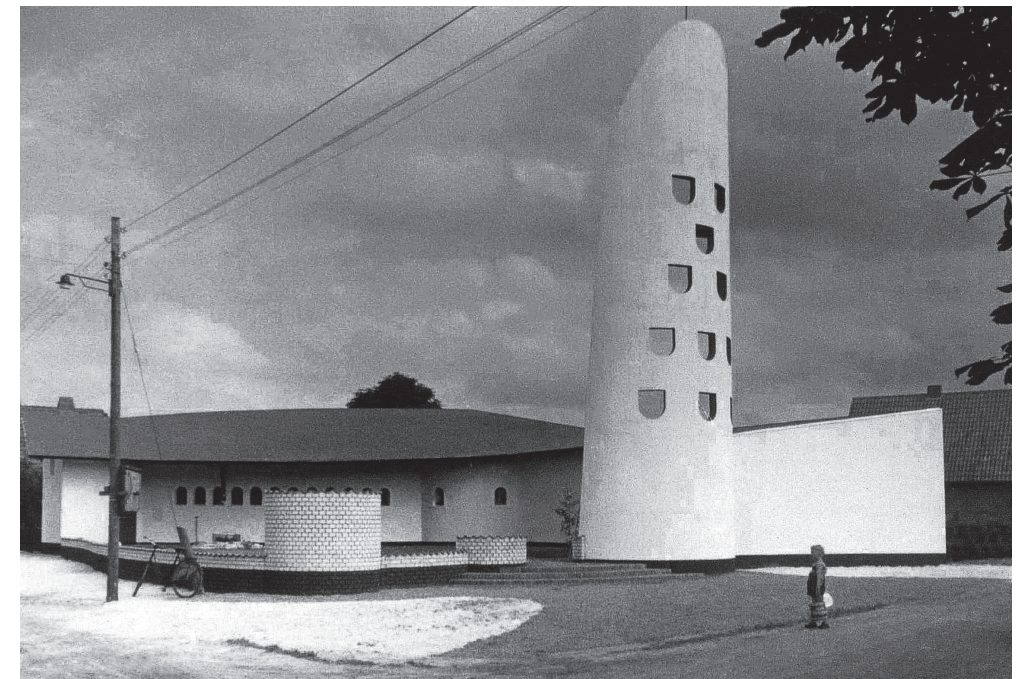
HI. Dreifaltigkeit, Schortens, Blick auf den Kirchplatz kurz nach Fertigstellung → S. 59
