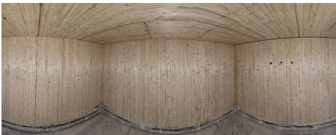
Bild 13 180° Drohnenaufnahme der Massivholzoberfläche nach Demontage der Brandschutzbekleidung für V0
