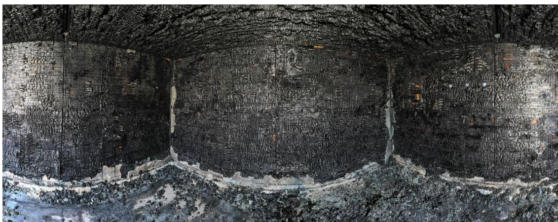
Bild 15 180° Drohnenaufnahme der Massivholzoberfläche nach Demontage der Brandschutzbekleidung für V1
