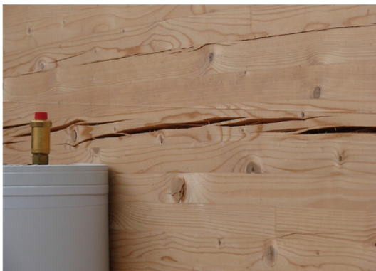
(a) Querkzugrisse BSH-Träger, u_{BSH} \approx 7\% (Bild: A. Brunauer)
