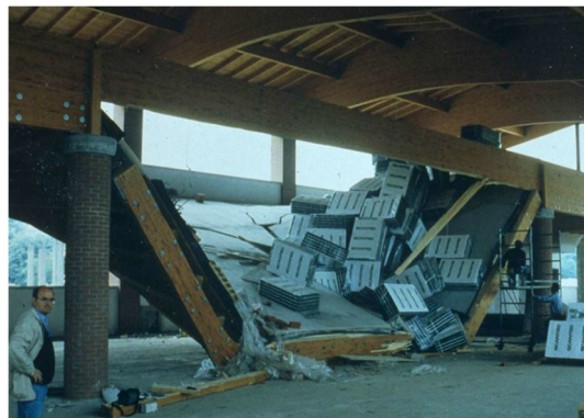
(d) Querkzugversagen einer BSH-Pfette Bild: Kreuzinger (Winter 2006b)
