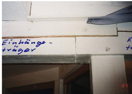
(b) Ausklindung (Bild: Kreuzinger, LS HBB TUM)
