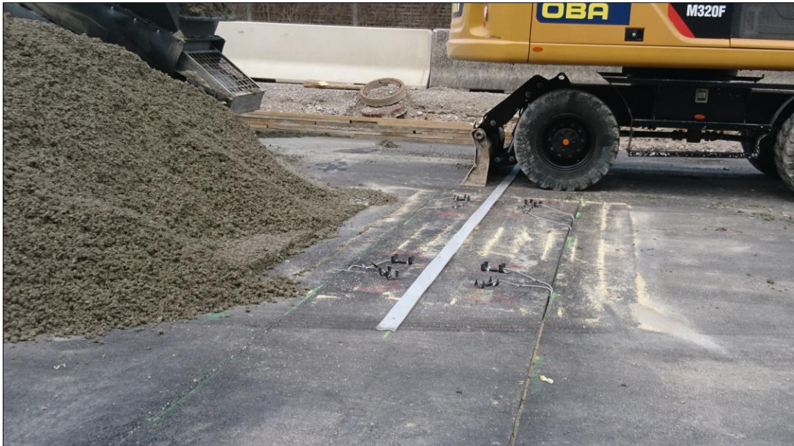
Abbildung 64: Feldversuch - Flachdrain und Messtechnik vor Betonage
