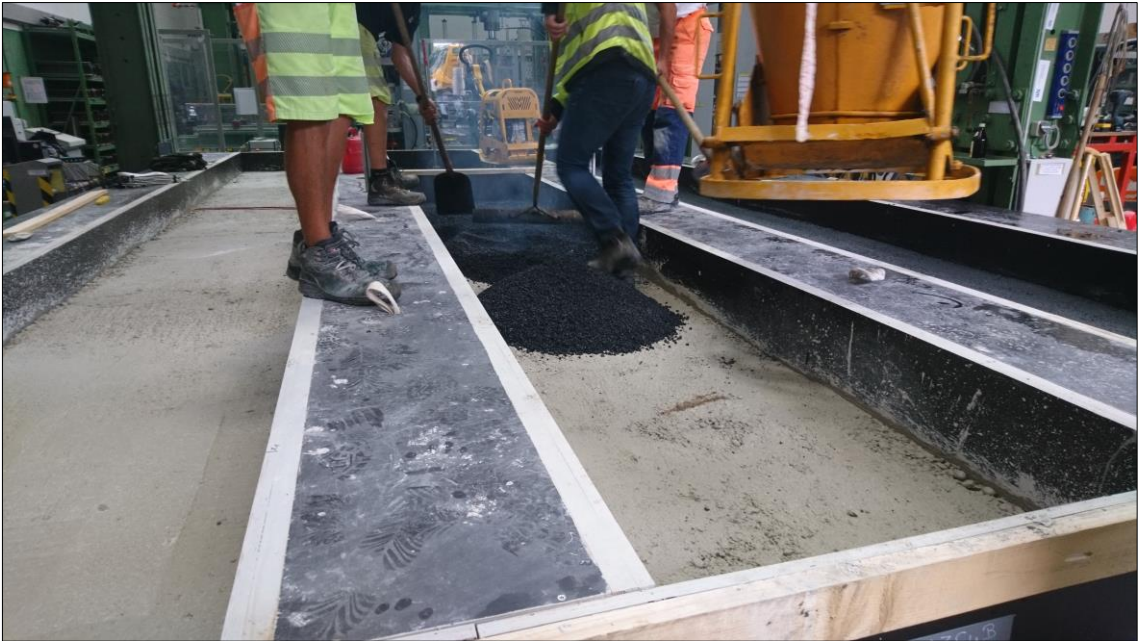
Großversuch - Einbau AZS
