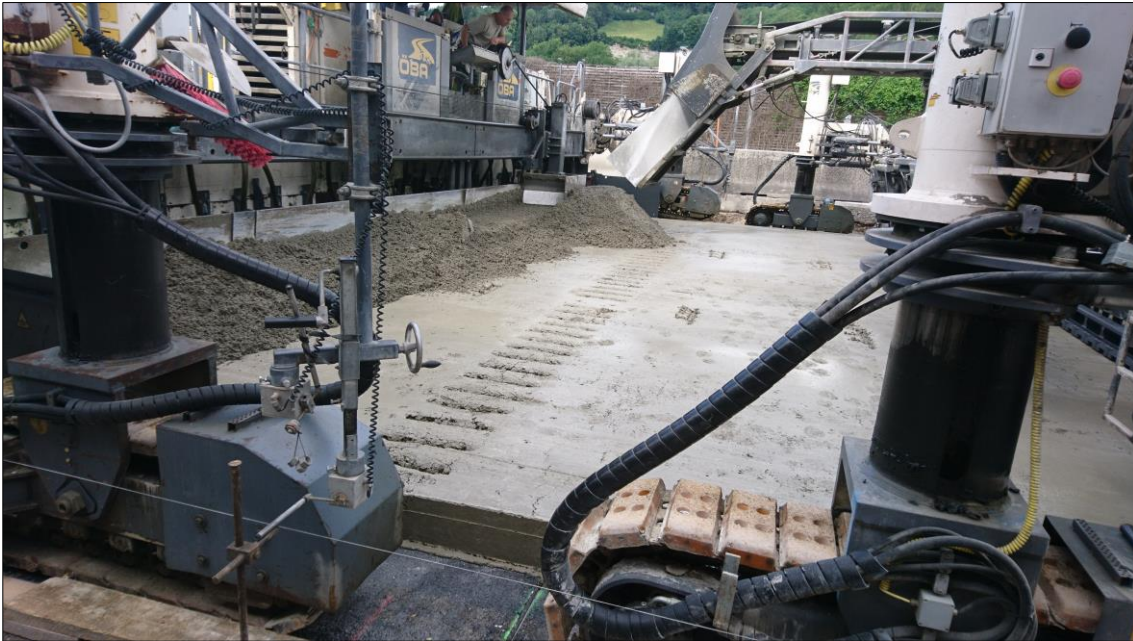
Feldversuch - Betonage Oberbeton im Messtechnikbereich
