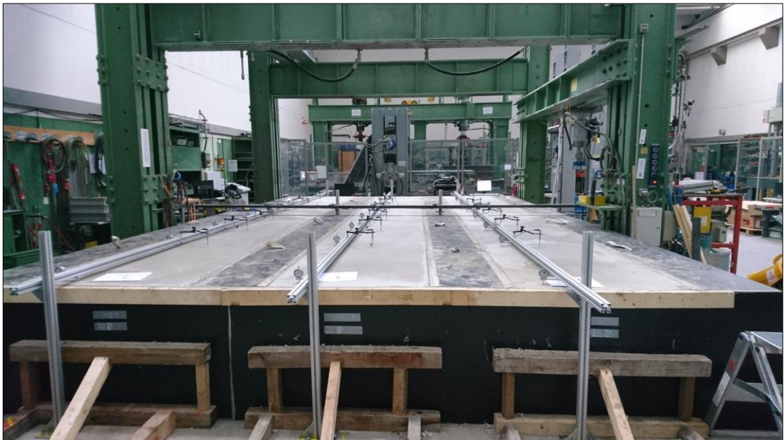
Großversuch - Messbasis nach Betonage
