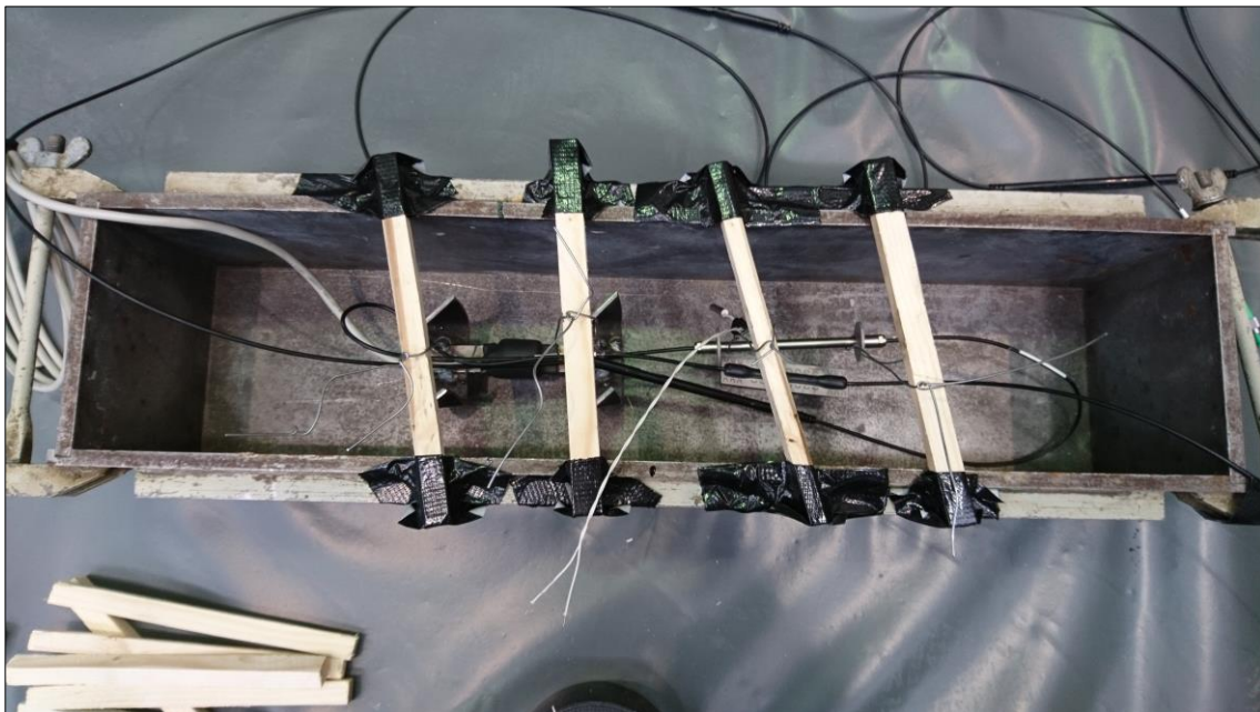
Stufe 0 - Eingebaute Messtechnik vor Betongage
