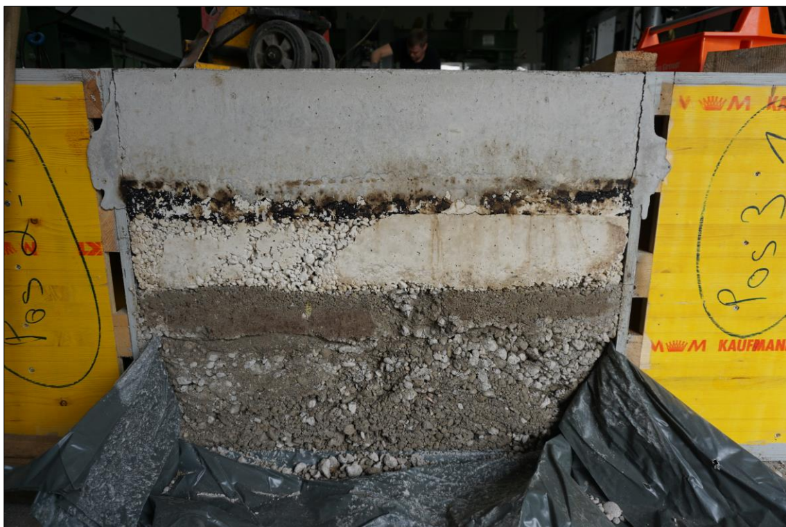
Großversuch - Schichtaufbau (AZSuB)
