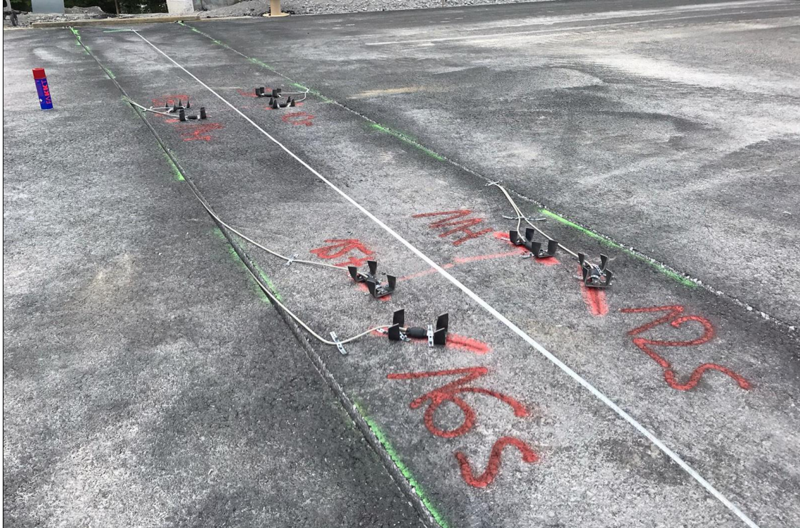
Abbildung 55: Feldversuch - Einbau Messtechnik (Bereich B)
