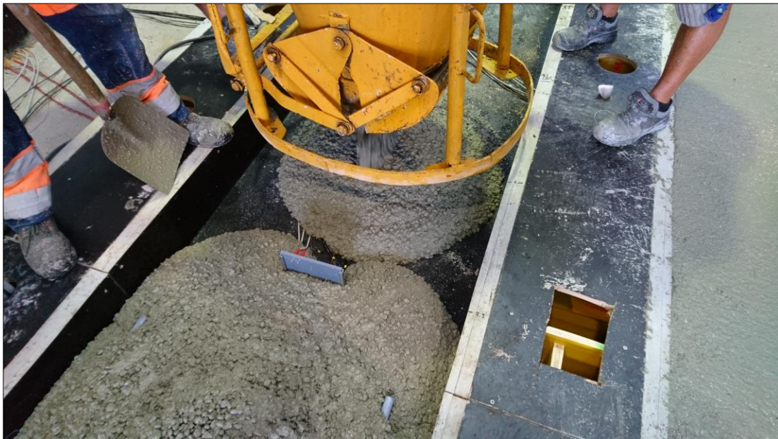
Großversuch - Betonage im Messtechnikbereich
