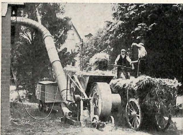
Abb. 7: Elektrisch angetriebenes Fördergebläse
