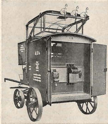
Abb. 2: Transformatorwagen mit niedergelegtem Mast 1930
