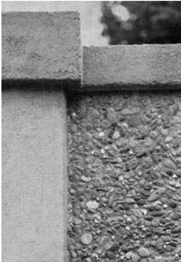
Abb. 7: Im Contex-Verfahren hergestellte Betonoberfläche (sichtbare Zuschläge)
