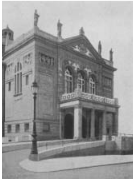
Abb. 45: Prinzregententheater, bauzeitliche Aufnahme
