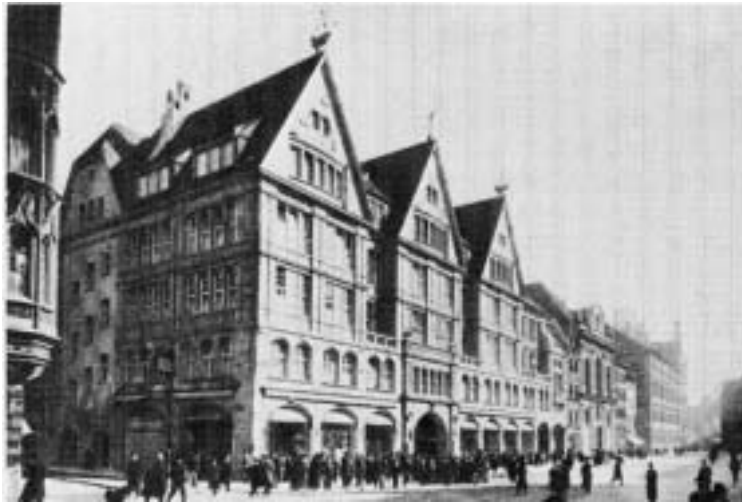
Abb. 50: Warenhaus Oberpollinger, bauzeitliche Aufnahme
