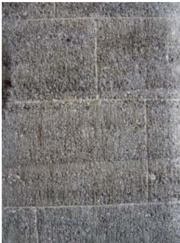
Abb. 37-40: St. Rupert, Details der Betonwerksteinoberflächen. Fugenbild nachträglich in die Oberfläche eingearbeitet.
