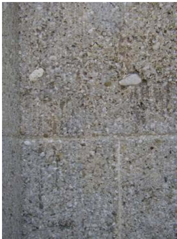
Abb. 37-40: St. Rupert, Details der Betonwerksteinoberflächen. Fugenbild nachträglich in die Oberfläche eingearbeitet.
