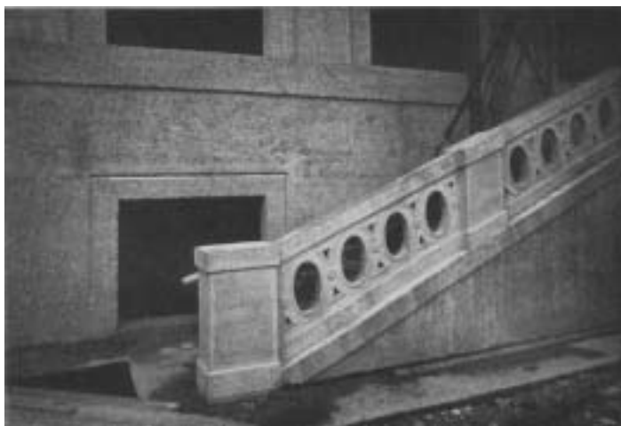
Abb. 19-22: Bauzeitliche Aufnahmen der Sichtbetonfassaden des Deutschen Museums
