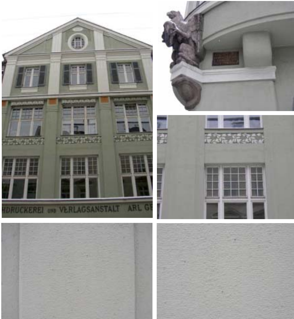
Abb. 28-32: Details der Fassade
