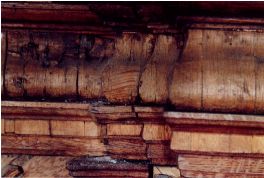
Abbildung 89: Rechte Stallenreihe, Stalle 16, Gebälk der Dorsale, durchgeschliffenes Furnier
