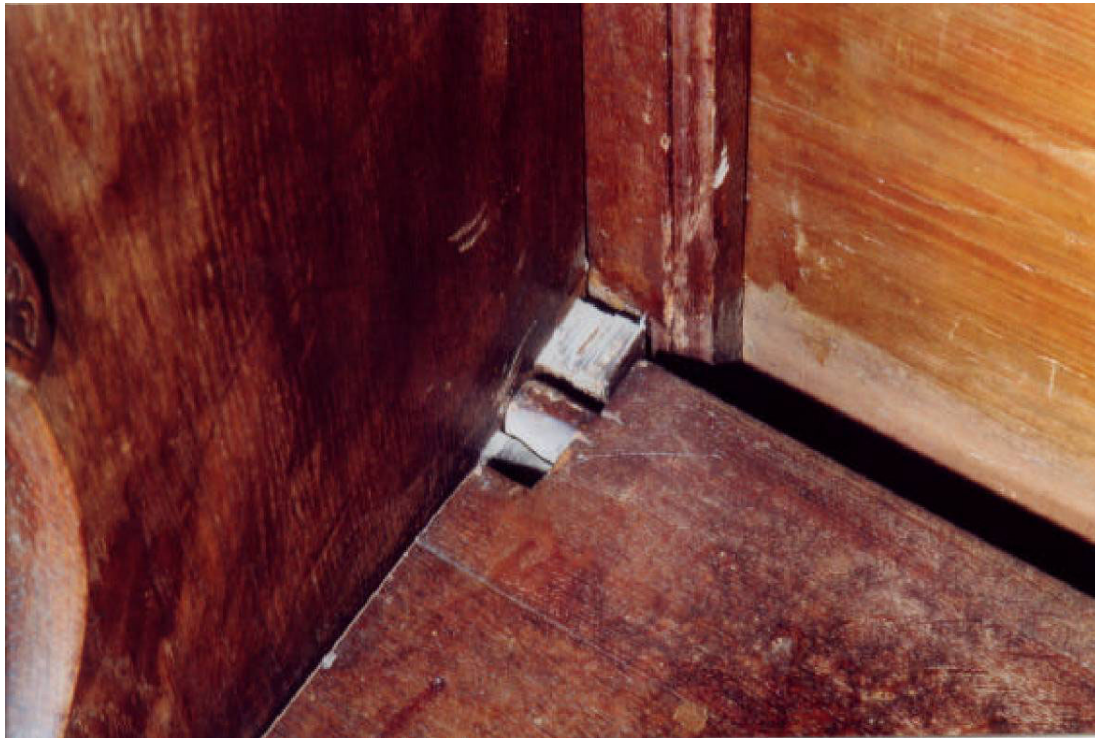
Abbildung 104: Stalle 7, reparierter linker Klappmechanismus
