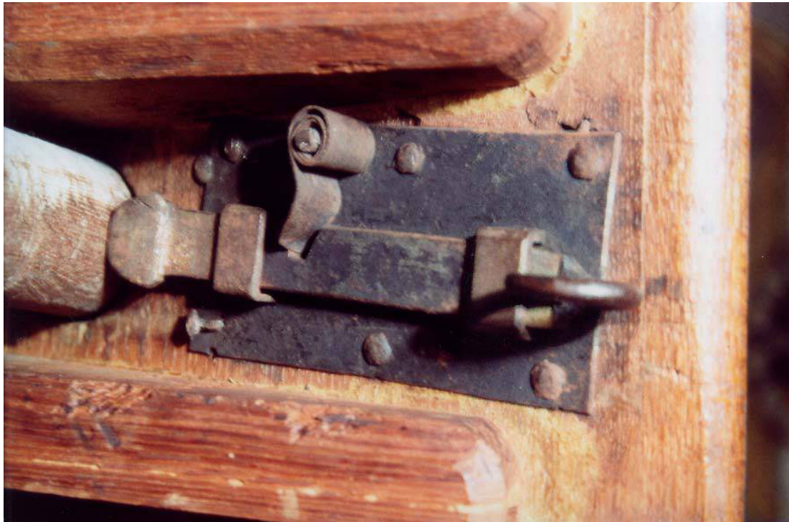
Abbildung 21: Abtstuhl, Pult, Eisenhaken zur Fixierung von einschiebbaren Halterungen
