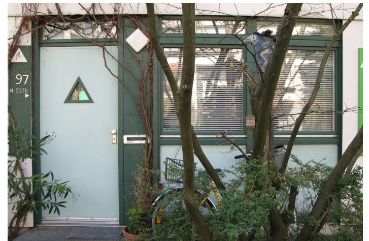
Abbildung 22: Fassadenaufbau der Flachbereichsbauten in der Straßbergerstraße (oben) und in der Nadistraße (unten)
