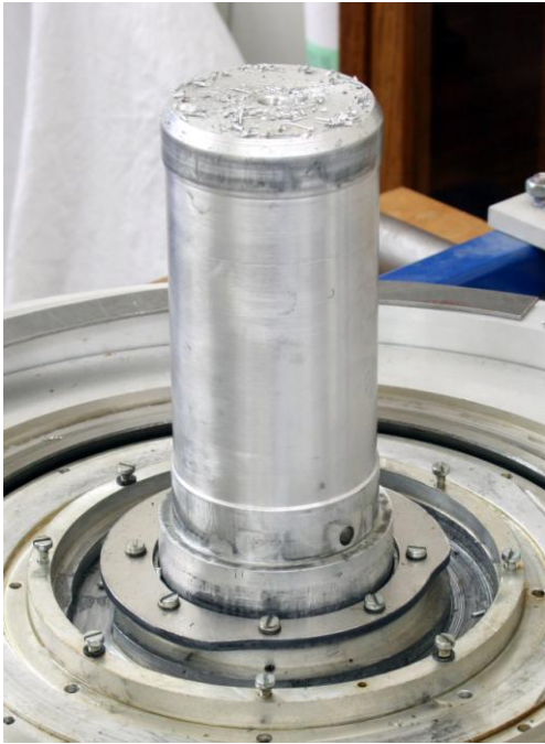
Abb. 38: Helixturm, Zentralzylinder, während der Demontage
