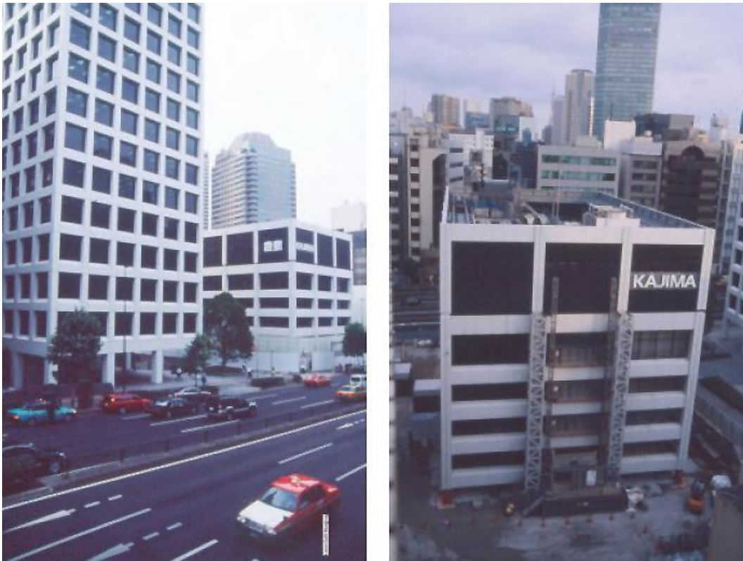
Abb. 82: Japan, automatisierter Rückbau (im linken Bild eines von drei Hochhäusern, das noch vollständig steht, daneben ein im Rückbau befindliches; Drittes rechts in der Abb. nahezu gänzlich zurückgebaut)
