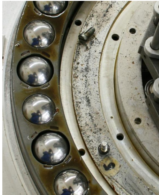
Abb. 39: Helixturm, Detail Kugellager und Grundplatte, während der Demontage
