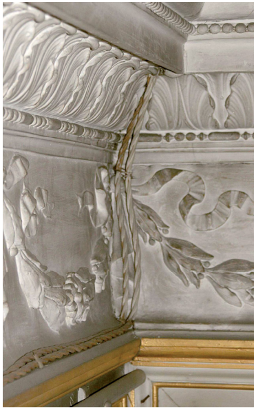
05.113/1 Süd-West-Ecke verseilte Litzenleitungen (Foto: Edlmann 2009).
