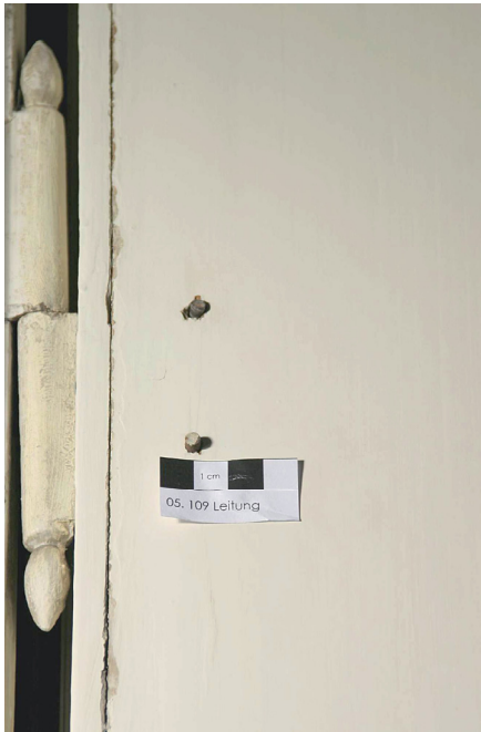
05. 09/5: Leitungsenden in ca. 2 m Höhe in der Türleibung zu 05.111 (Foto: Edlmann 2009).
