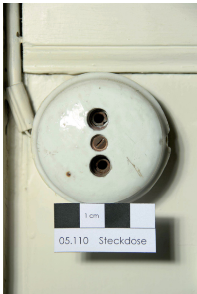
05.110/10 Steckdose Typ S 512 der Siemens-Schuckertwerke rechts neben südlichem Fenster (Foto: Edlmann 2009).
