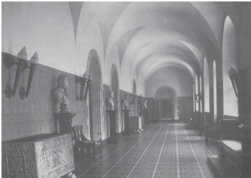
Abb. 85: Korridor des Kaisers mit elektrischen Fackeln (GULCZYNSKI; SCHWENDEMANN 2003, S. 97).
