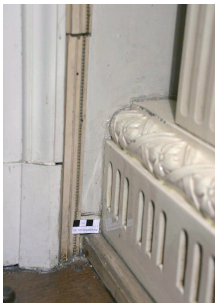
05.109/3: Klingelleitung an der Westwand, links neben dem Kamin (Foto: Edlmann 2009).
