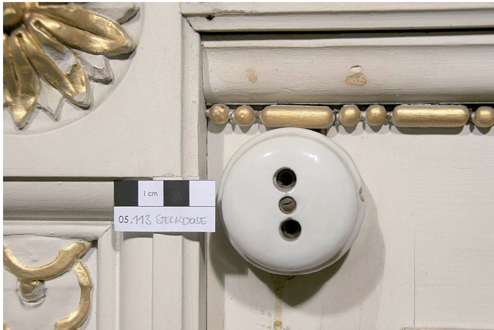
5.113/13 Steckdose Typ S512 der Siemens-Schuckertwerke rechts neben Kamin (Foto: Edlmann 2009).
