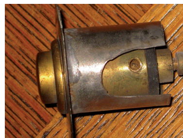
05.113/19 Demontierter Klingelknopf (Foto: Edlmann 2009).
