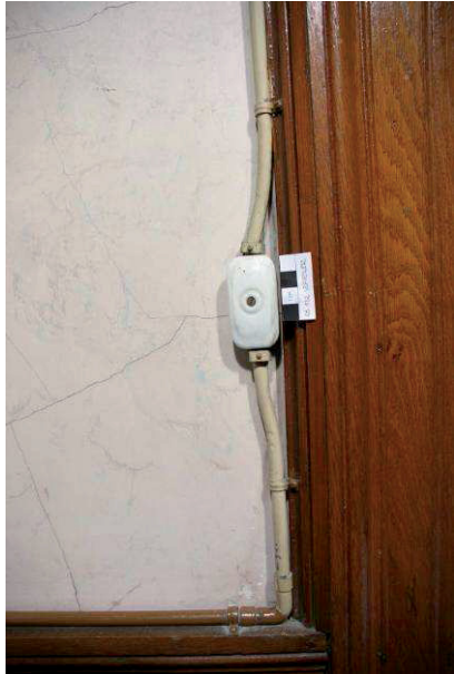
05.112/11 Klemmhäuschen links neben südlichem Fenster (Foto: Edlmann 2009).
