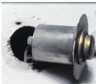
05.113/18 Demontierter Klingelknopf (Foto: Edlmann 2009).
