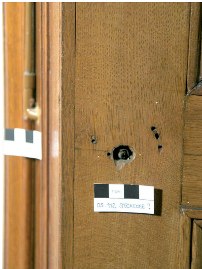
05.112/7 Demontiertes Installationselement am südlichen Fenster (Foto: Edlmann 2009).
