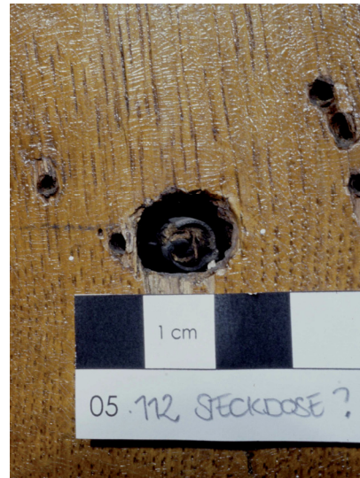
05.112/8 Demontiertes Installationselement am südlichen Fenster, Detail (Foto: Edlmann 2009).
