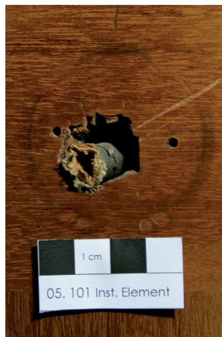
05.101/2: Leitungsende in der Toilette des Kaisers (Foto: Edlmann 2009)
