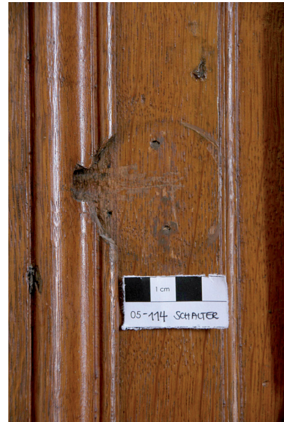
05.114/4 Demontiertes Installationselement an der Tür zu 05.113 (Foto: Edlmann 2009).
