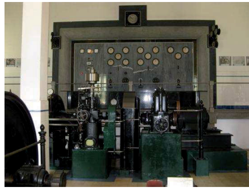
Abb. 95: Maschinensatz von 1925 und 1933, im Hintergrund Schalttafel aus Marmor (Foto: Edlmann 2009)
