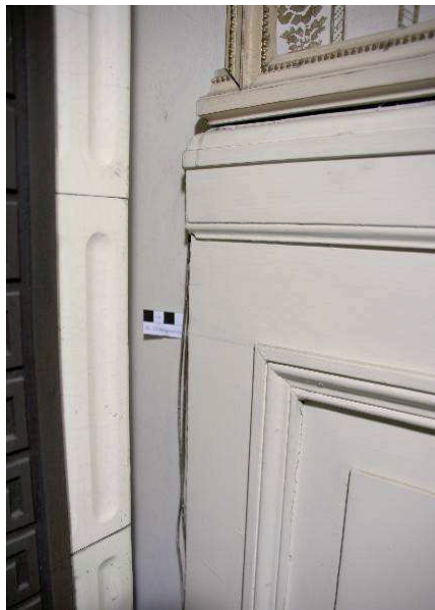
05.109/1: Klingelleitung an der Nordwand, rechts neben dem Kamin (Foto: Edlmann 2009).
