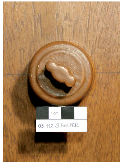
05.112/10 Schalter mit Drehhahn von Voigt & Haeffner am mittleren Fenster (Foto: Edlmann 2009).
