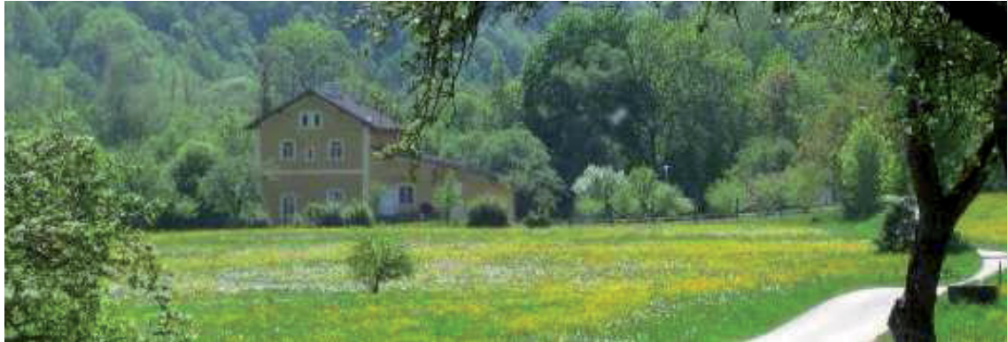
Abb. 94: Elektrizitätskraftwerk Marienberg bei Burghausen (Foto: Edlmann 2009)
