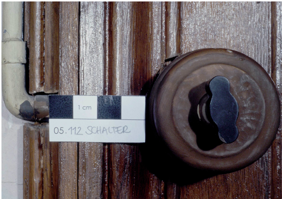
05.112/3 Schalter mit Drehhahn von Voigt & Haeffner links neben der Tür zu 05.114 (Foto: Edlmann 2009).
