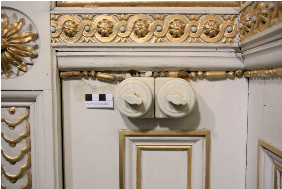
5.113/11 Türsockelapparate von Voigt & Haeffner, rechts neben Tür zu 05.114 (Foto: Edmann 2009).
