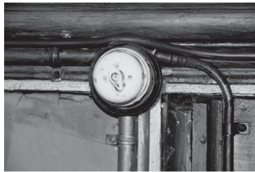
Abb. 88: Stillgelegter Schalter mit Drehhahn, Schloss Erbach (Foto: Edlmann 2009)
