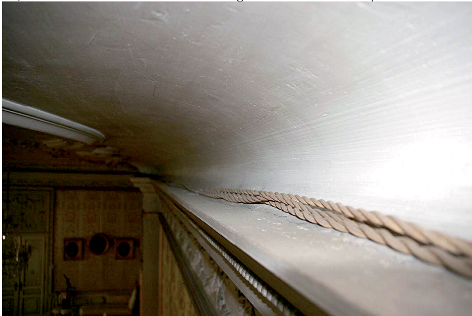
05.113/5 Von der Nord-West-Ecke in die Süd-Ost-Ecke verlaufende verseilte Litzenleitungen (Foto: Edlmann 2009).
