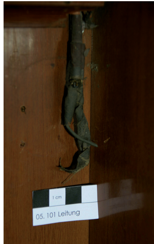
05.101/4: Leitungsende unterhalb des Fensterbretts in der Toilette des Kaisers, Detail (Foto: Edlmann 2009)
