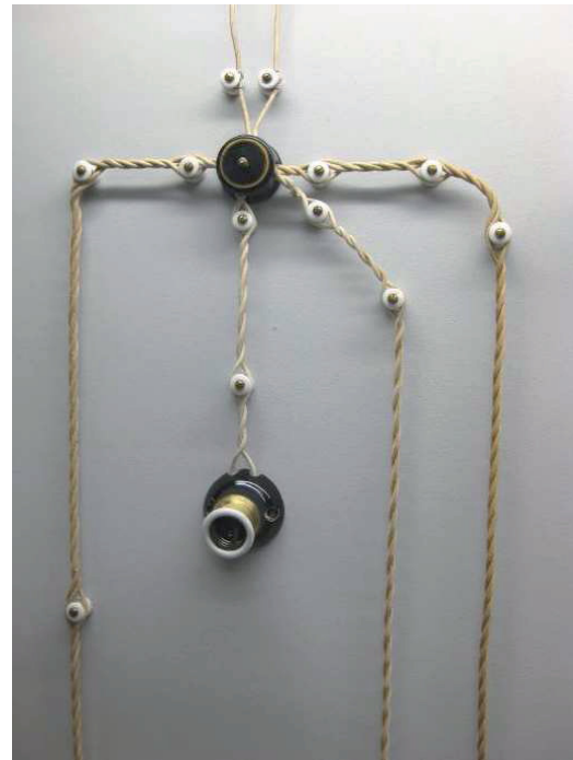
Abb. 98: Verlegung von Litzenleitungen auf Isolierrollen (Foto: Edlmann 2009)
