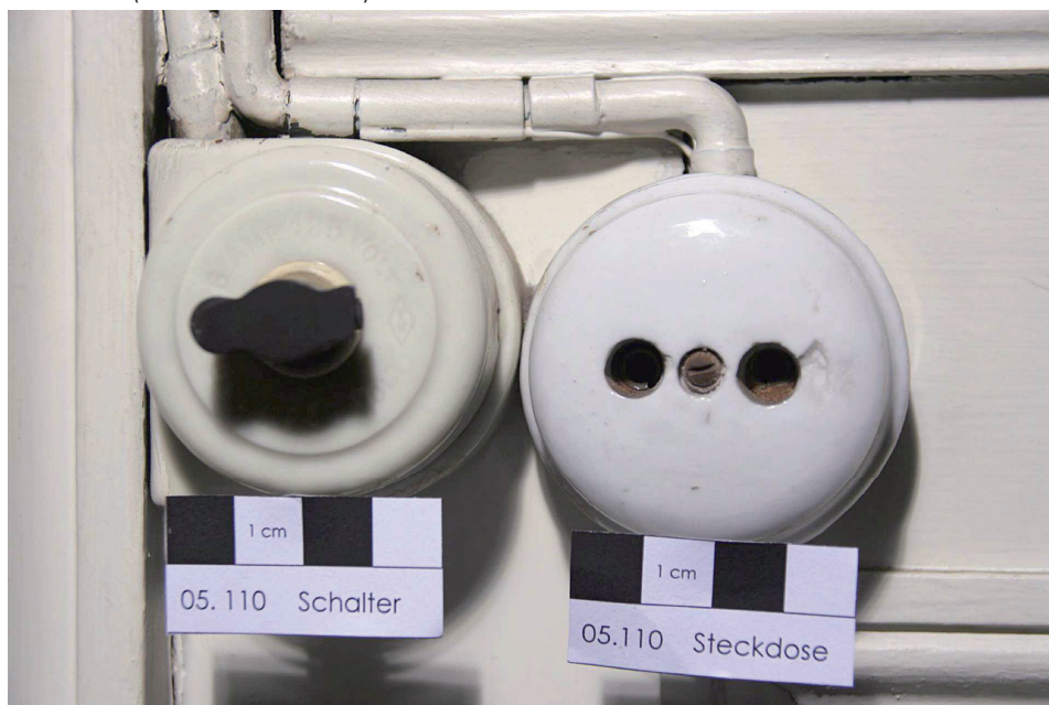
05.110/12 Türsockelapparat von Voigt & Haeffner und Steckdose Typ S 512 der Siemens-Schuckertwerke rechts neben Tür zu 05.108 (Foto: Edlmann 2009).
