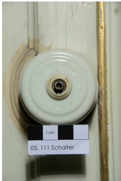
05.111/1 Schalter mit fehlendem Drehhahn von Voigt & Haeffner neben Tür zu 05.113 (Foto: Edlmann 2009).
