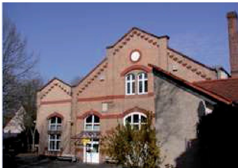
Abb. 106: Elektrizitätswerk, heute Jugendtreff „E-Werk“ ( http://www.e-werk-hg.de/ )
