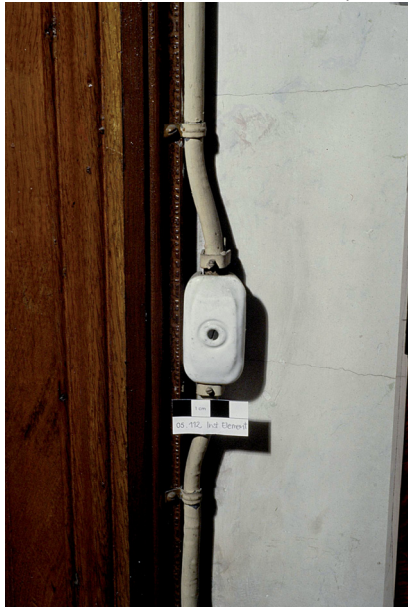
05.112/12 Klemmhäuschen rechts neben nördlichem Fenster (Foto: Edlmann 2009)
