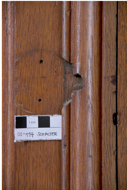
05.114/3 Demontiertes Installationselement an der Tür zu 05.112 (Foto: Edlmann 2009).
