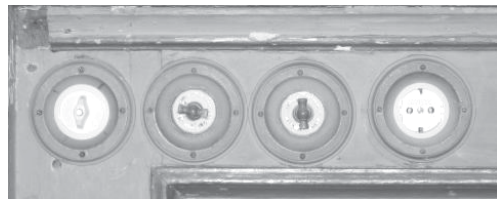
Abb. 81: Innen zwei historische Unterputz-Schalter, außen ein moderner Schalter und eine Steckdose (Foto: Edlmann 2009 mit Genehmigung der SPSG).
