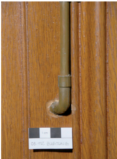
05.112/9 Rohrdrahtleitung (Foto: Edlmann 2009).
