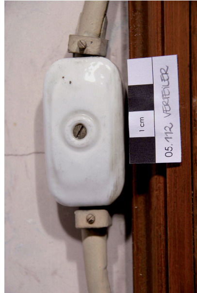
05.112/12 Klemmhäuschen rechts neben nördlichem Fenster, Detail (Foto: Edlmann 2009).
