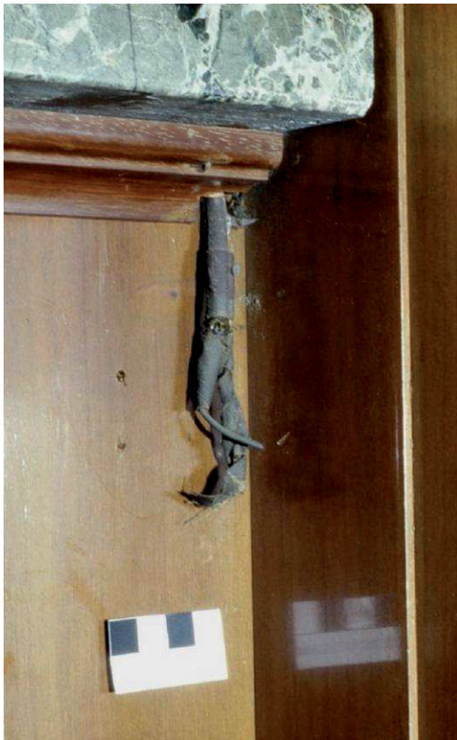
05.101/3: Leitungsende unterhalb des Fensterbretts in der Toilette des Kaisers (Foto: Edlmann 2009)
