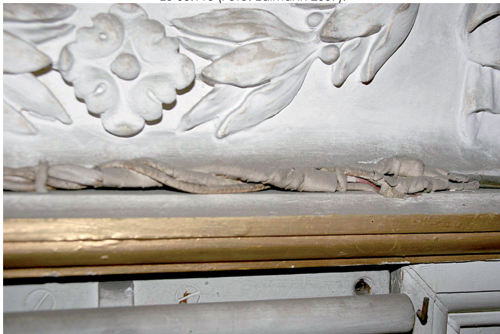
5.113/10 Rohrleitung und freiliegendes Leitungsende, hinter die Wandvertäfelung führend, über Tür zu 05.115 (Foto: Edlmann 2009).
