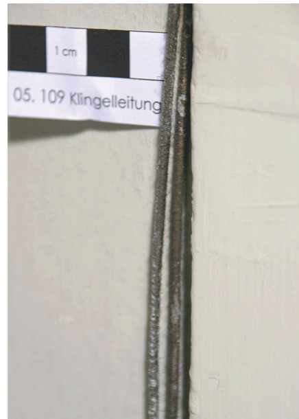
05.109/2: Klingelleitung an der Nordwand, rechts neben dem Kamin, Detail (Foto: Edlmann 2009).
