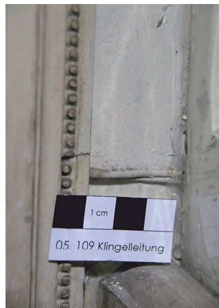
05.109/4: Klingelleitung an der Westwand, links neben dem Kamin, Detail (Foto: Edlmann 2009).
