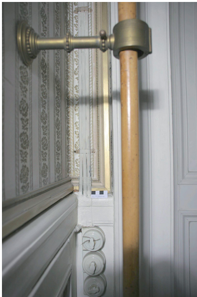
05.110/13 3 Türsockelapparate von Voigt & Haeffner neben Tür zu 05.111 (Foto: Edlmann 2009).
