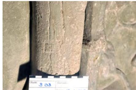
Abb. 196: Rissystem parallel zum Lager des Steins am Bein des Ritters.
