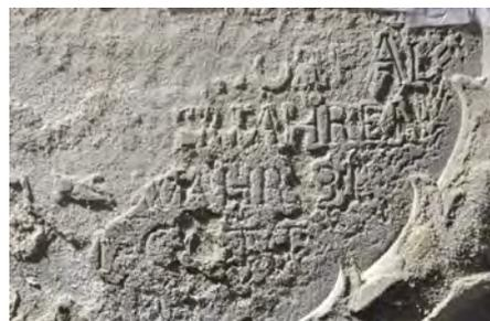
Abb. 288: Die Schrift der Kartusche wird stellenweise nur noch durch Reste der Ölfarbfassung auf der Oberfläche gehalten.
