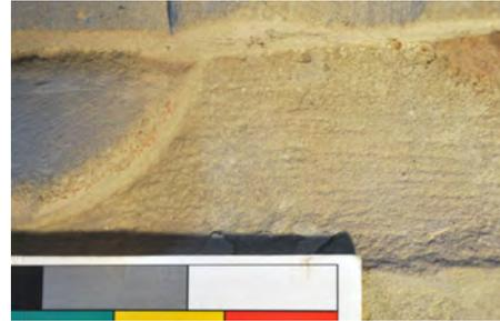
Abb. 22: Im Streiflicht werden Spuren eines Zahneisens sichtbar.
