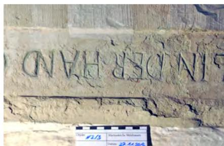
Abb. 70: Sandende Oberfläche im Schriftbereich mit Ausbrüchen im Streiflicht.
