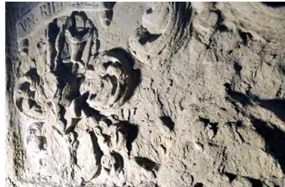
Abb. 13: Völlig aufgelöstes Korngefüge aufgrund von Salzsprengung bei Epitaph S 12.
