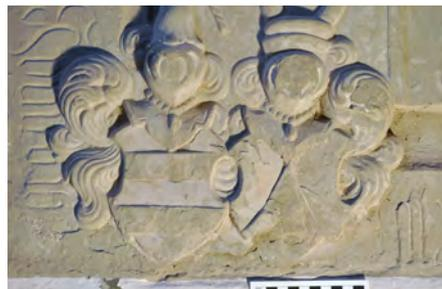
Abb. 23: Abgeplatzte dünne Schalen in der unteren linken Ecke des Epitaphs.
