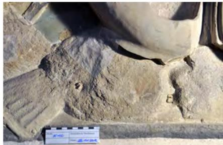
Abb. 138: Die Oberfläche ist wegen einer abgefallenen Schale verloren. Darunter sind drei Holzdübel zu sehen, deren Funktion unklar ist.
