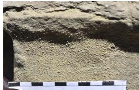
Abb. 305: Die Oberfläche am Sockel der rechten Säule ist stark abgewittert und sandet ab.
