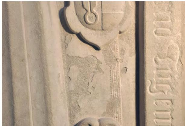
Abb. 44: Die Oberfläche des Steins platzt in sehr dünnen Schalen ab.
