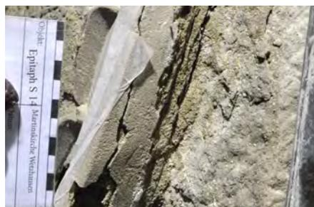
Abb. 289: Die Kartusche schiefert schichtenparallel auf.
