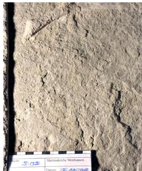
Abb. 15: Oberfläche des Hintergrunds bei Epitaph S 3. Auch hier ist die originale Oberfläche durch Abschuppen und Absanden verloren gegangen.
