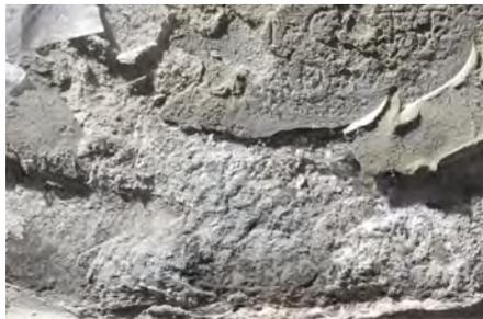
Abb. 287: Im unteren Bereich des Gedenkesteins sind große Flächen von einer Salzkruste bedeckt.
