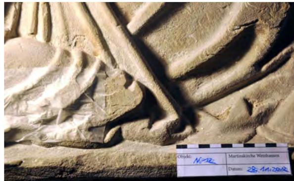
Abb. 162: Im unteren Bereich des Epitaphs schuppt der Stein parallel zum Lager stark auf.
