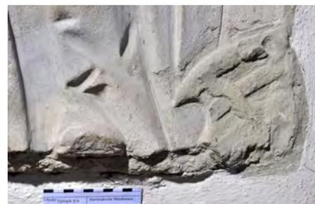
Abb. 109: Bei der Renovierung im 20. Jahrhundert sind Ausbrüche „steinfarben“ übermalt worden.
