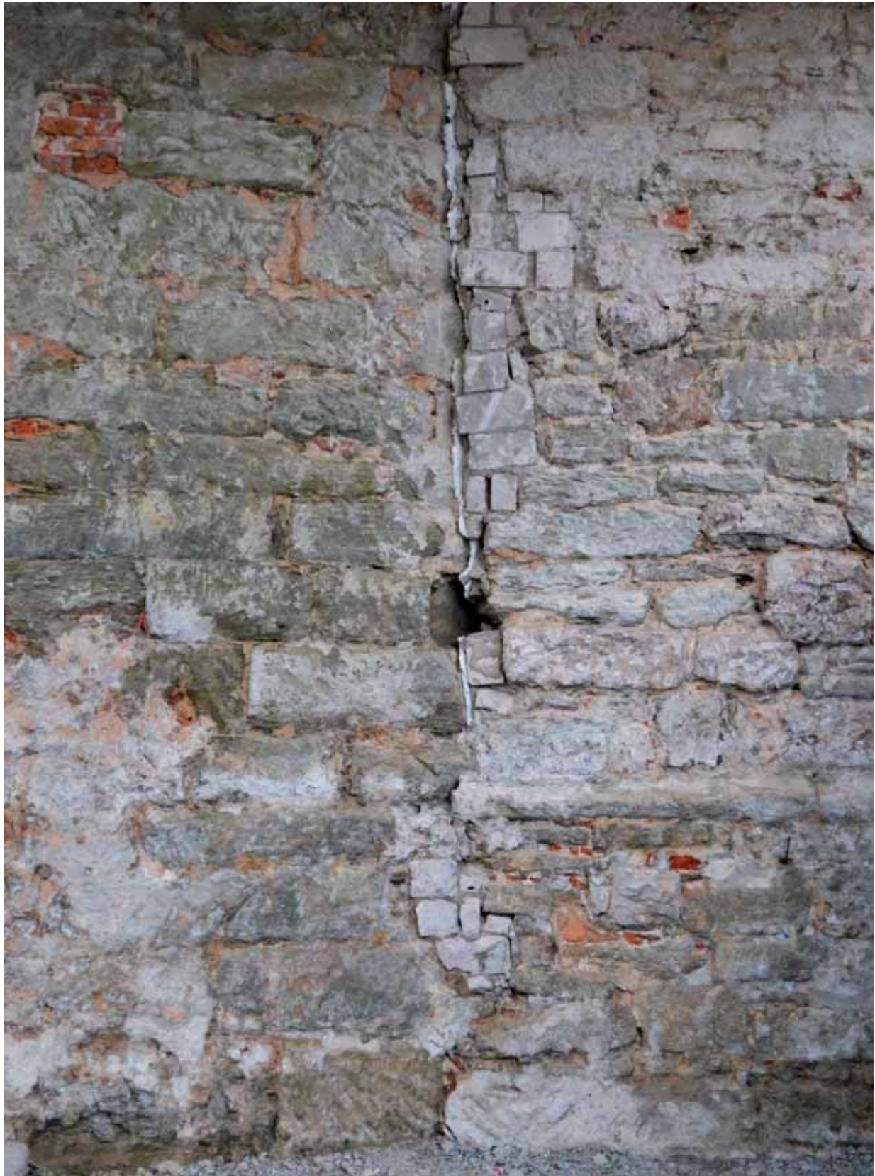
Abb. 63 Baunaht, mit Kalksteinen zugesetzt
