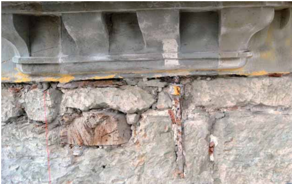
Abb. 53 Schlauder und Holzbalken unter östlichem Erker
