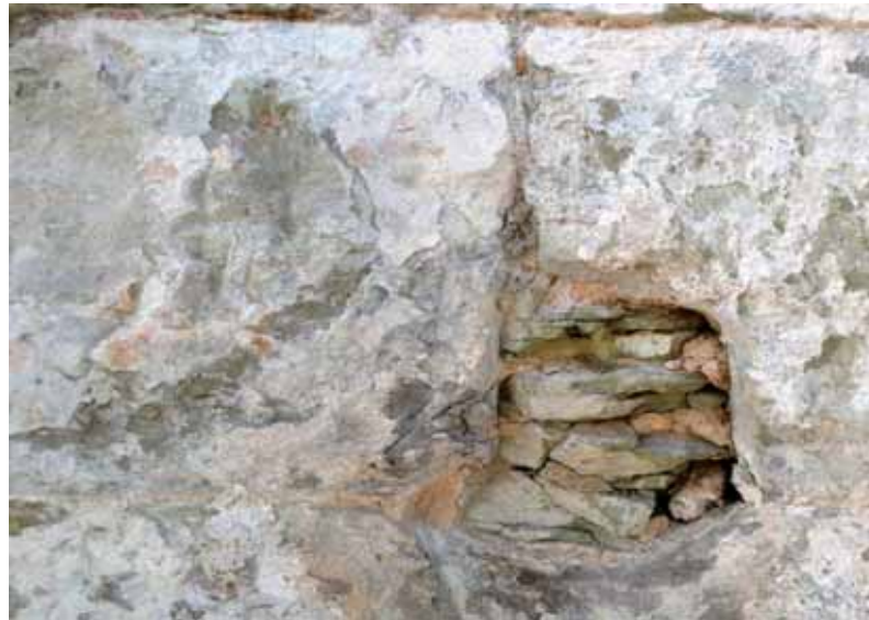
Abb.44 Zugesetztes Gerüstloch
