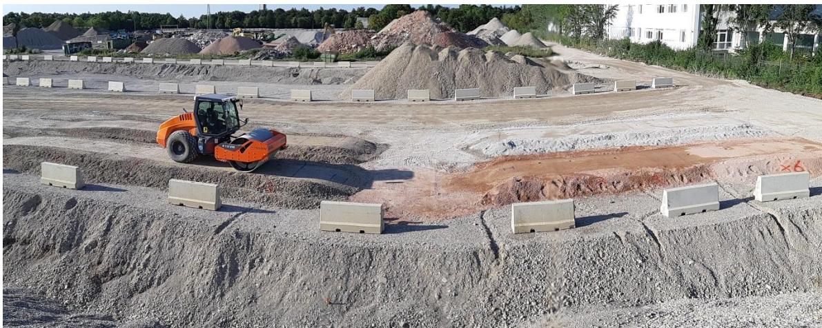
Abbildung 167: Im Zuge der Messkampagne im August 2020 erstellte Probefelder aus natürlichem Brechkorn 0/32, RC B 0/16, RC M 0/22 und natürlichem Rundkorn 0/45 (im Uhrzeigersinn beginnend von links oben)
