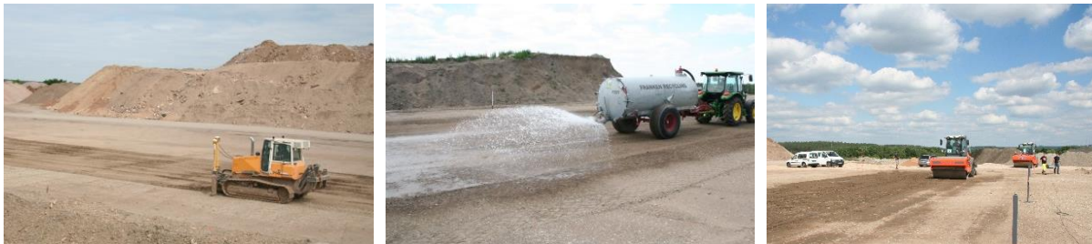
Abbildung 163: Vorbereitung des Planums am Beispiel der Versuchsfeld B – Planieren (links), Wässern (Mitte), Abwalzen (rechts)
