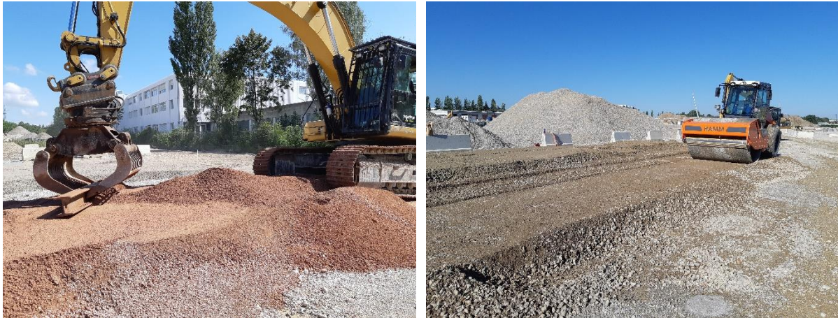
Abbildung 166: Arbeitsschritte zur Herstellung der Probefelder auf der Versuchsfläche C – Verteilen von RC M 0/22 (links) und Verdichtung des natürlichen Brechkornes 0/32
