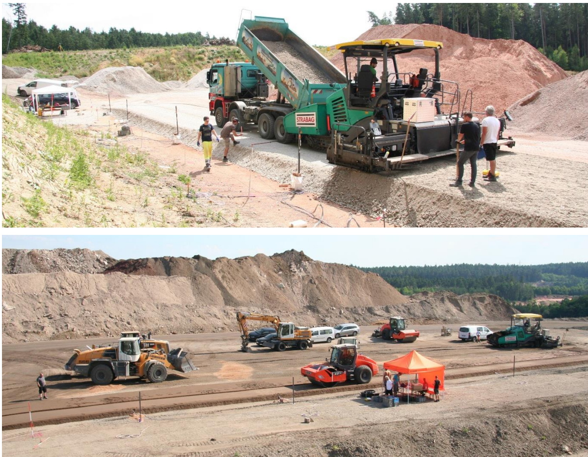
Abbildung 164: Einbau von RC M 0/56 mm (Lage 2) auf der Versuchsfläche A (oben) und Verdichtung von RC M 0/4 mm (Lage 1) auf der Versuchsfläche B (unten)
