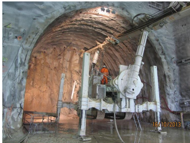
Figure 10-2 : Tunnel Descendant Ouest de Monaco (AFTEs GT7)
