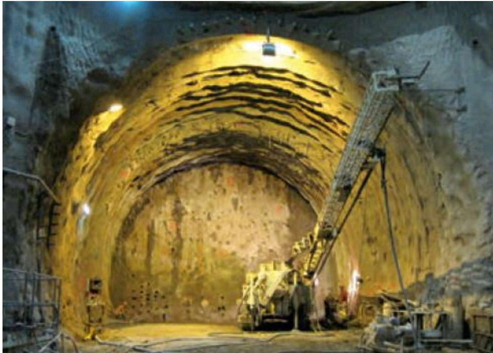
Figure 10-12 : Sappanico Tunnel, Italy (source TES N°249, Juin/May 2015)
