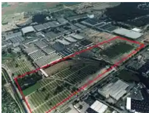
Gelände für die temporären Bauten
