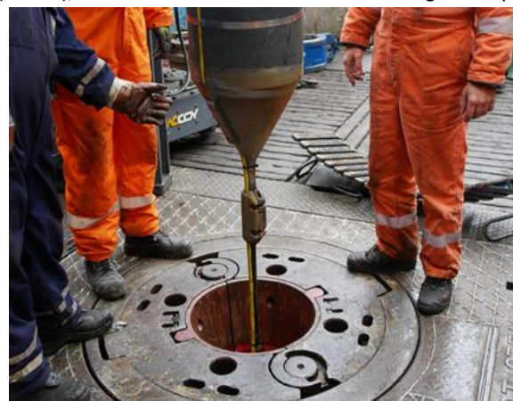
Abbildung 5: Einbau des Glasfaserkabels in die Thermalwasser Produktionsbohrung
