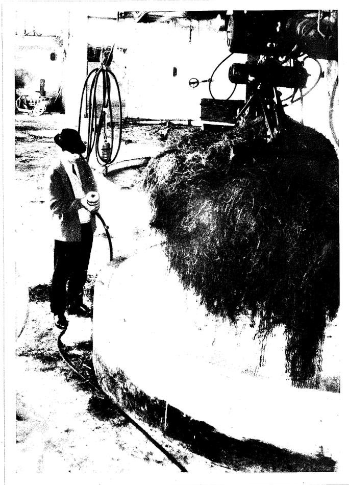
Abb. 1: Entnahme der Silage aus einem Tiefsilo mit Hilfe eines Selbstgreifers
