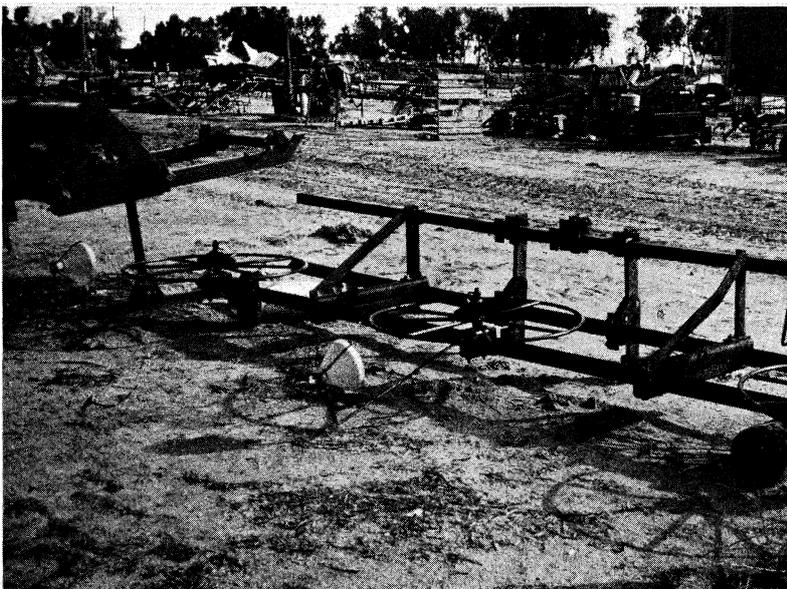
Abb. 9 b: 3-reihiges Tropfrohr-Abrollgerät (links für Waagrechte, rechts für senkrechte Trommelachse)
