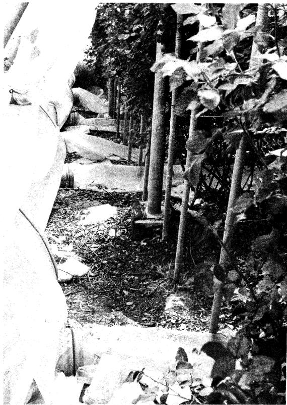
Abb. 2: Gewächshaus-Luftheizung über perforierte Boden-Polyäthylensschläuche
