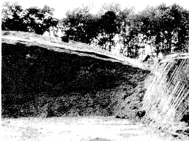
Abbildung 21 : Erdsilo mit Holzbohlen ausgelegt, Folienabdeckung
