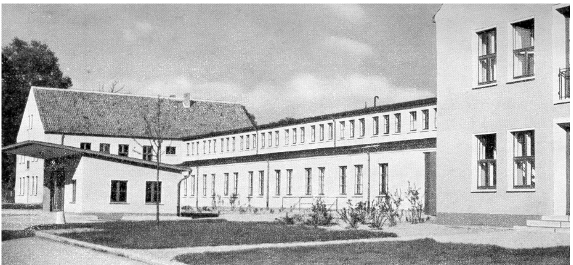
Bild 5: Neue Gebäude und Einrichtungen für die Forschung
