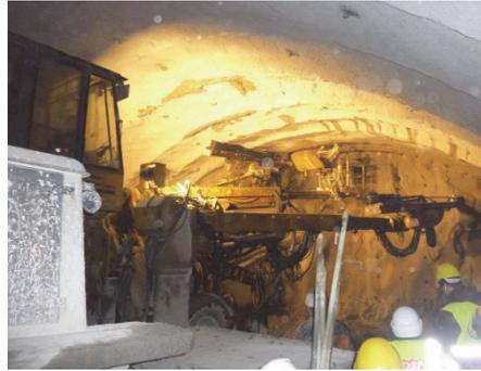
**Abbildung 6: Bohren der Bohrlöcher für Sprengvorgang**
