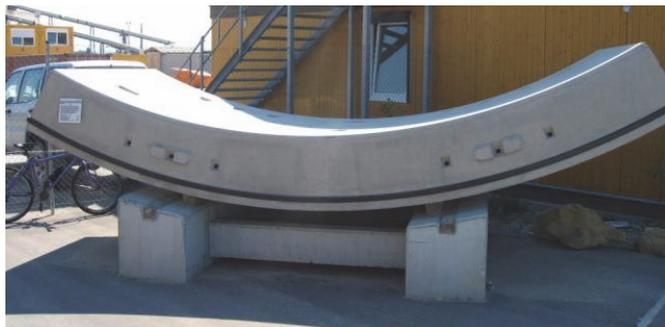
**Abbildung 8: Betontübbing**
