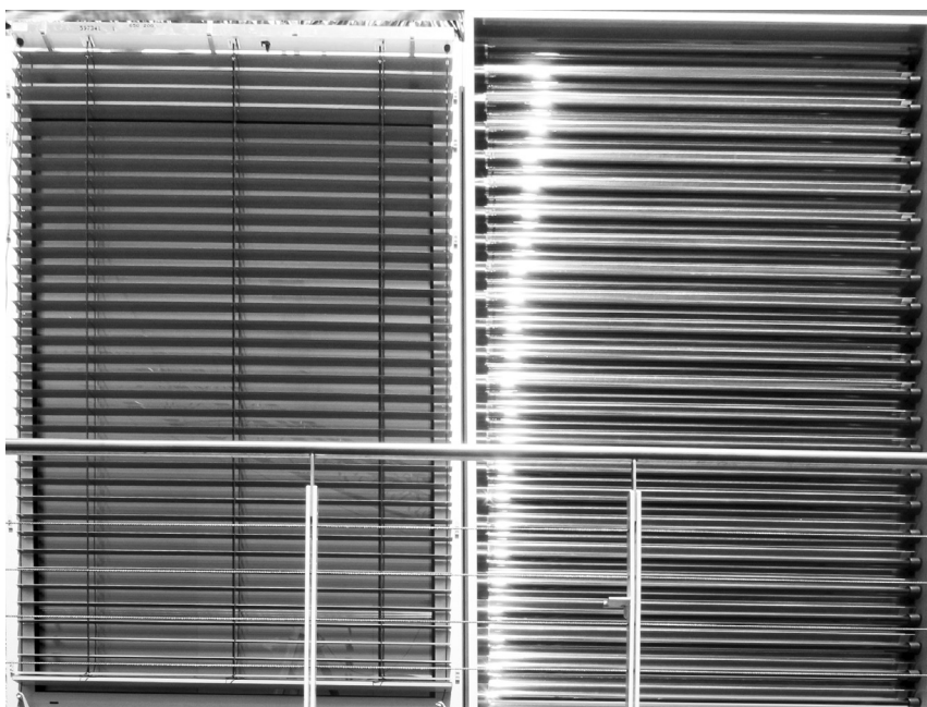
[Abb. 1.58_2] Kollektorfassade und Lamellenraffstore
