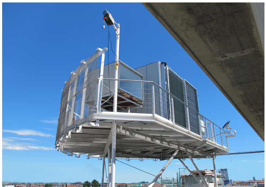
[Abb. 1.31_1] Die Messeinrichtung - Solarstation der TUM
