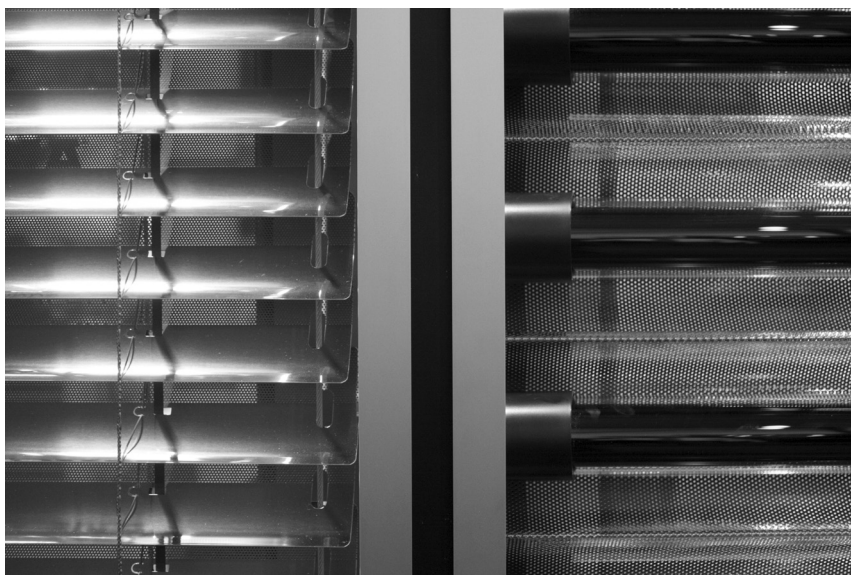
[Abb. 1.58_1] Kollektorfassade (re.) und Lamellenraffstore (li.)
