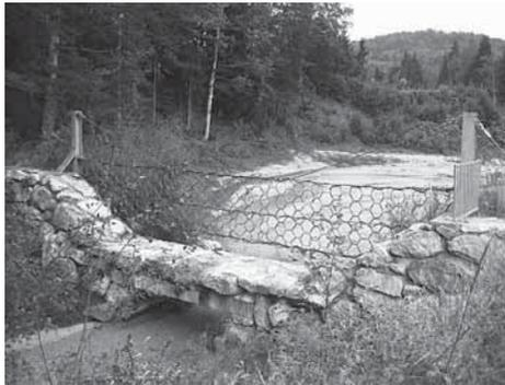
Abb. 2.33: Seilnetzsperrung über Geschiebesperre (Kranzbach, Oberbayern, Foto: Asenkerschbaumer)
