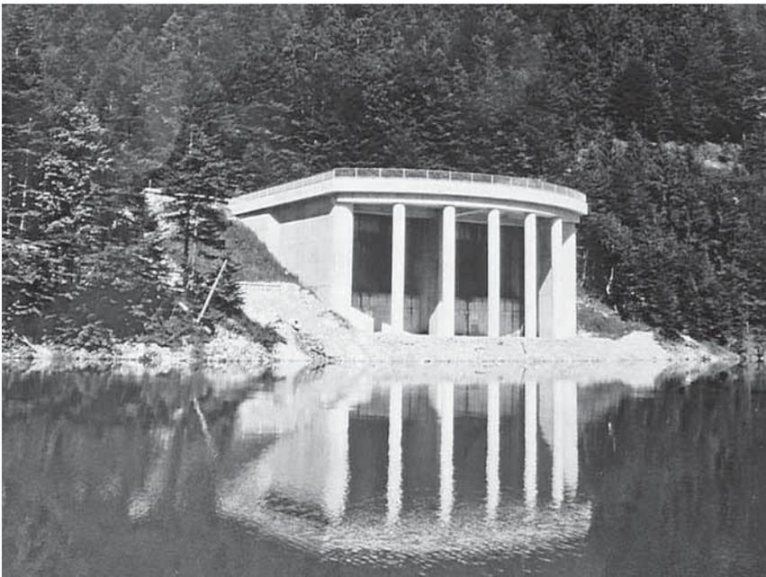
Abb. 4.19: Einlaufbauwerk der zusätzlichen neuen HWE2 im Prototyp
