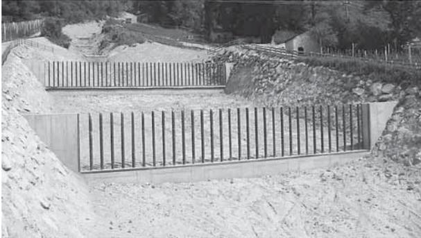
Abb. 2.1: Beispiel für Schwemmholzrechen mit einer Anordnung senkrecht zur Fließrichtung (Galsauerbach, Südtirol, Foto Asenkerschbaumer)
