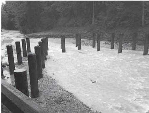
Abb. 2.4: Beispiel eines doppelreihigen V-förmigen Schwemmholtzrechens (Lainbach, Oberbayern, Foto Asenkerschbaumer)
