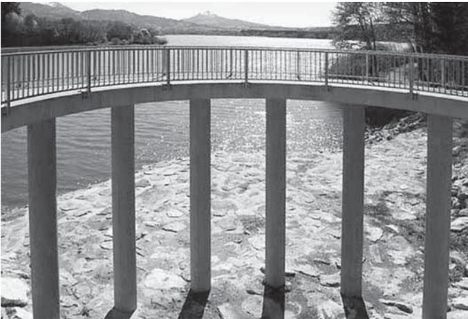
Abb. 4.9: Rechensäulen mit verbindender Aussichtsbrücke (Blick über den Stausee auf den namensgebenden „Wächter des Allgäus“)
