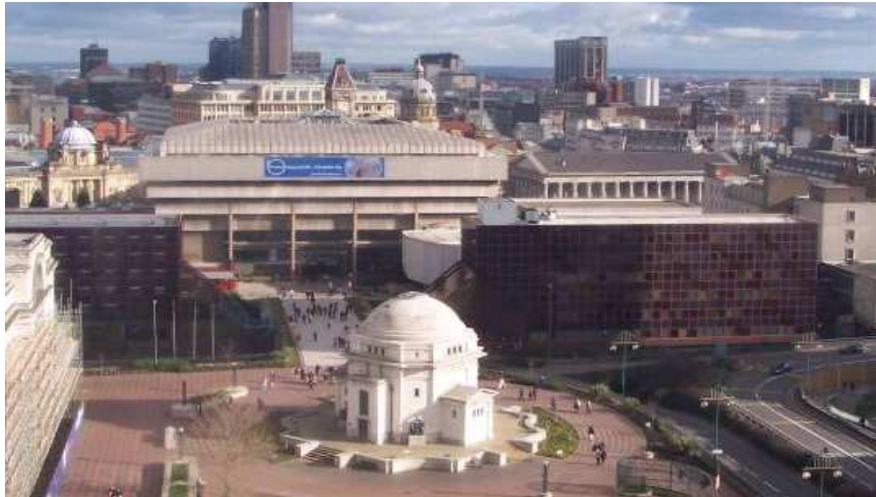
Bild 94: Stahlbetonsäulen Midlands, Großbritannien (Osborne, 1999, www.wikipedia.org , 2013)
