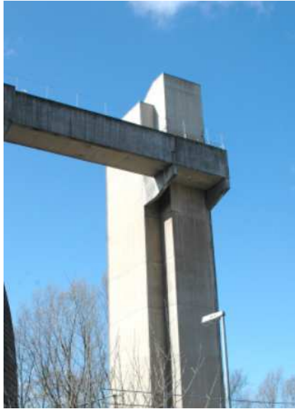
Bild 100: Stahlbetontreppenturmanlage bei Aachen, Deutschland (Gehlen et al., 2013)
