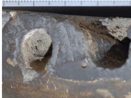
Abb. 63 Linkes Bohrloch: Farbspuren in der Einkerbung Rechtes Bohrloch: Farbspuren am rechten Bohrloch
