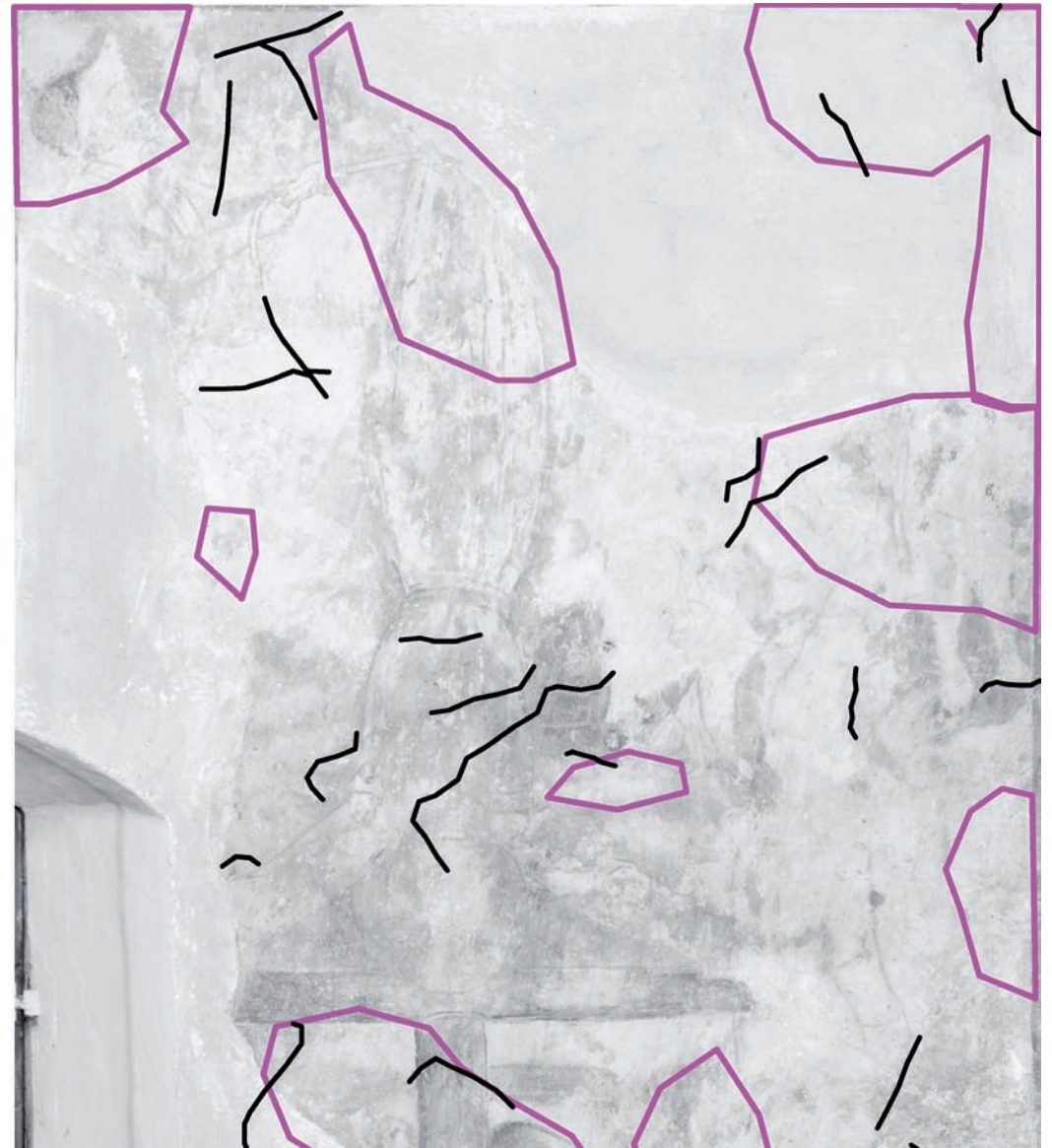
▲ Abb 462: BILDFELD 19, Kartierung, Schäden Putz, Maßstab ca. 1:10
