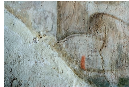
▲ Abb. 458: BILDFELD 19, Detail der Putzergänzung im unteren linken Bildbereich
