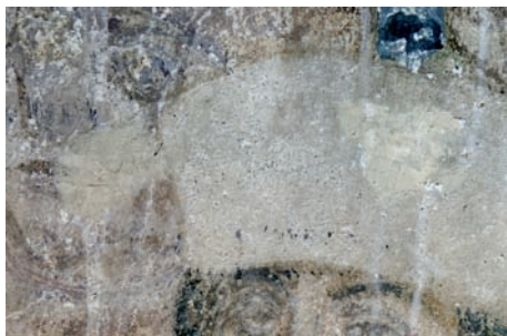
▲ Abb. 261: BILDFELD 7, Detail, Putzergänzungen neben und im Hut des Mannes mit der Schriftrolle
