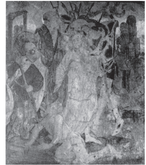
▲ Abb. 84: BILDFELD 2, Aufnahme vor der Restaurierung 1921/22 aus WOLFART 1909, S. 63
