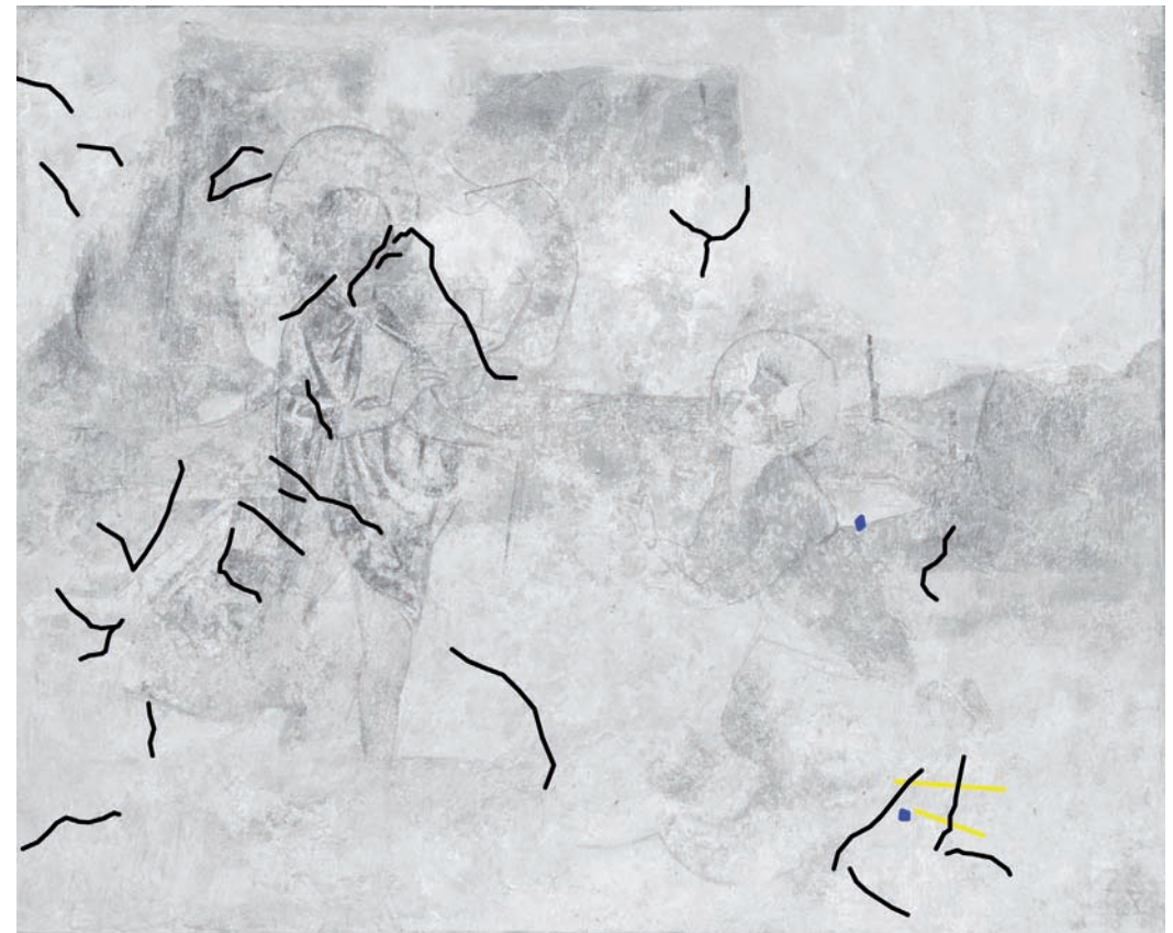
▲ Abb 428: BILDFELD 13, Kartierung, Schäden Malschicht, Maßstab ca. 1:10
