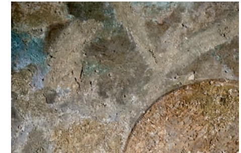
▲ Abb. 434: BILDFELD 14, kleine Putzausbesserungen oberhalb der Nimben
