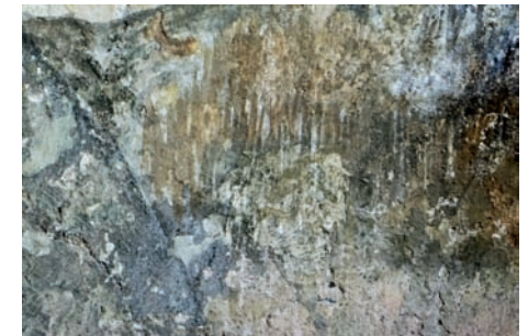
▲ Abb. 419: BILDFELD 13, Putzergänzung und Retuschen
