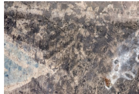
▲ Abb. 181: BILDFELD 4, Detail der Raumwand unterhalb des Fensters
