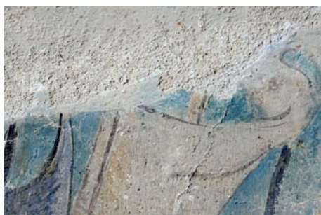
▲ Abb. 163: BILDFELD 4, Detail der Putzergänzung in der rechten Bildecke
