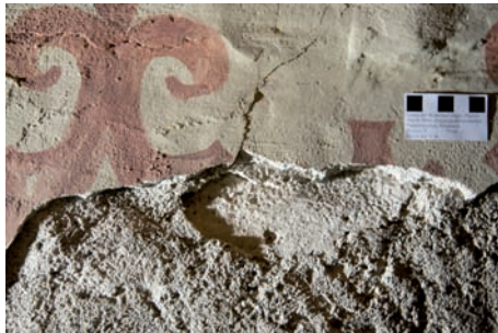
▲ Abb. 58: BILDFELD 1, weitere Ausbruchstelle in der Putzergänzung vermutlich vor 1909
