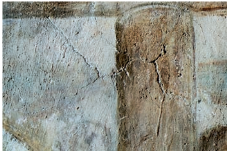
▲ Abb. 460: BILDFELD 19, Detail, Risse am Hauptbalken des Kreuzes
