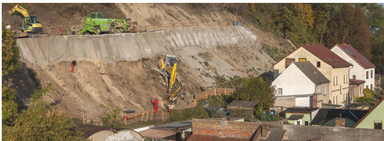
Abb. 2: Sicherung einer natürlichen Böschung im Geschiebemergel mit verankerten Spritzbetonpfählern und Drainagebohrungen in Oderberg/Ostbrandenburg (Photo J. Scherschel)
